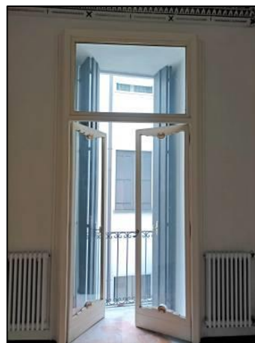
porta finestra lato strada
