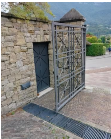
Locale rifiuti interno alla recinzione
