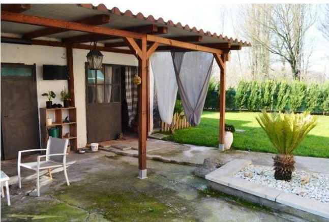
foto 10 - Scorcio del locale e tettoia non autorizzati
