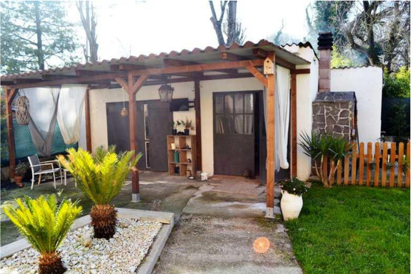
foto 8 - Prospetto nord dell'autorimessa dell'appartamento a piano T, con tettoia e adiacente locale
