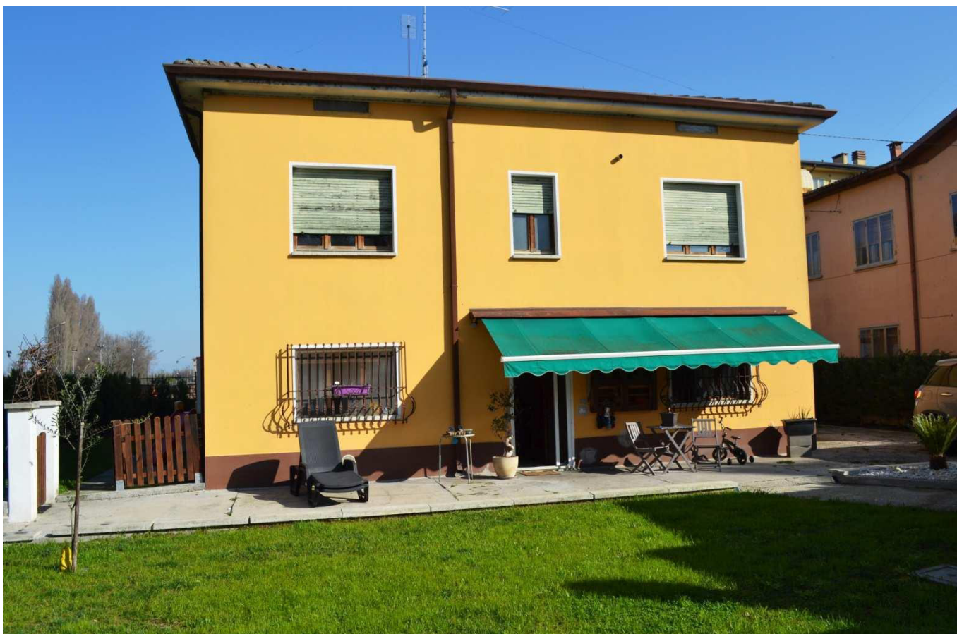
foto 4 - Prospetto sud dell'appartamento a piano T in via Mons. Fontana n. 21 - con ingresso dal giardino
