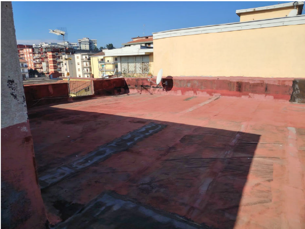
TERRAZZO DI COPERTURALATO SINISTRO
