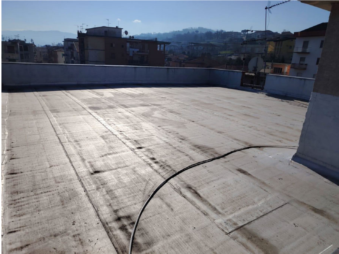
TERRAZZO DI COPERTURA LATO DESTRO
