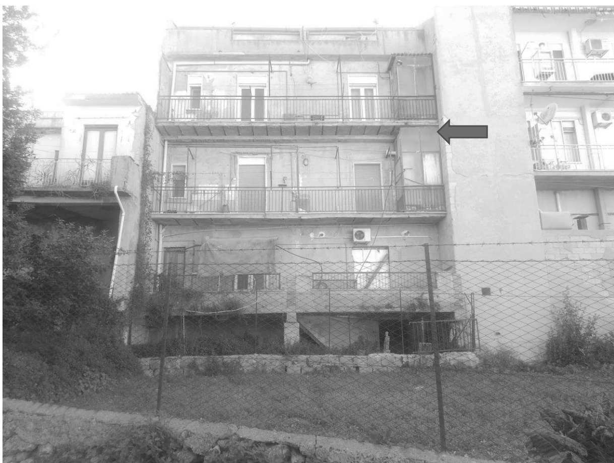
Figura 3 – Fotografie del prospetto principale e posteriore del fabbricato
