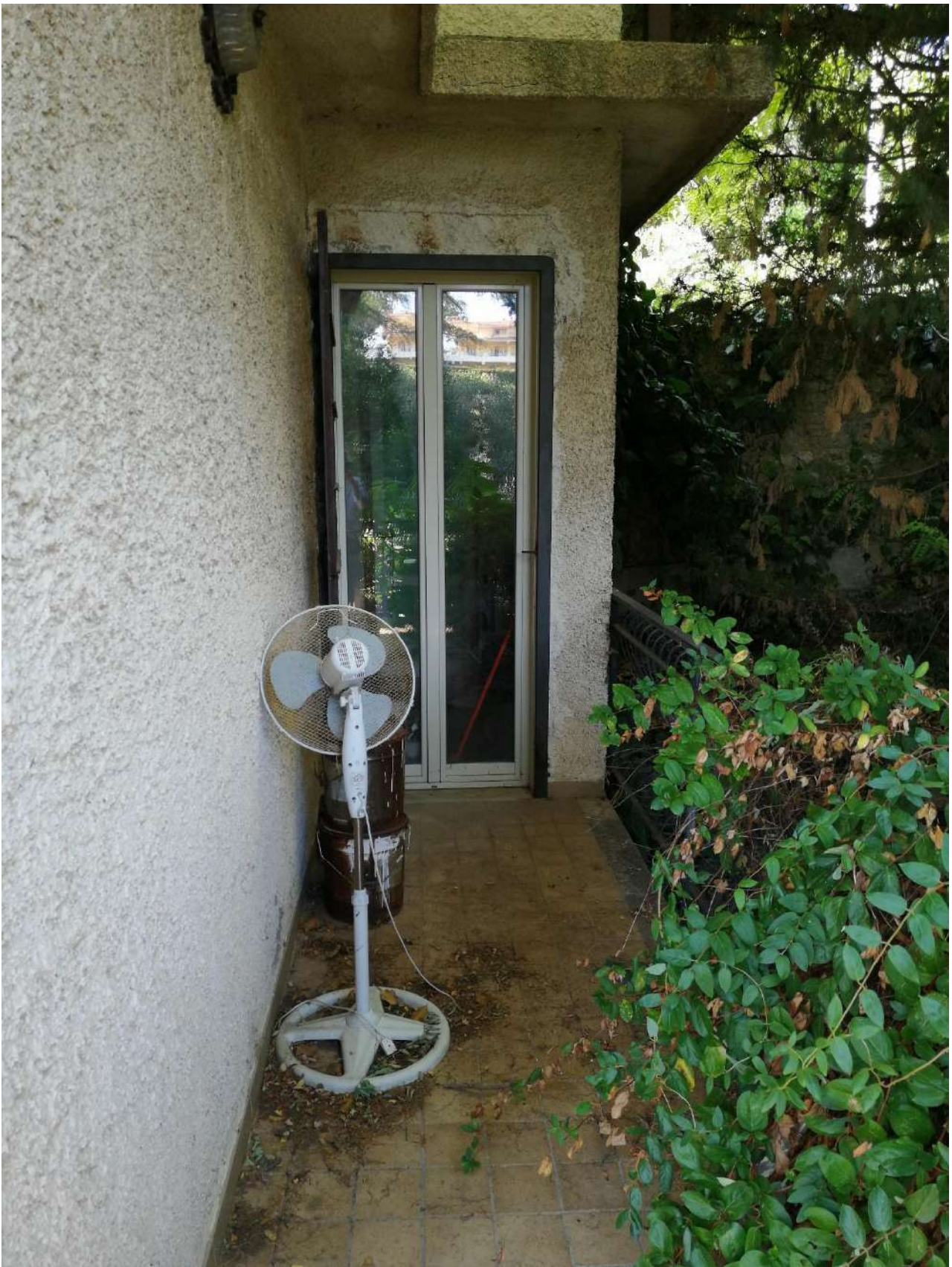
Foto n° 31 Particolare balcone angolare Piano 2
