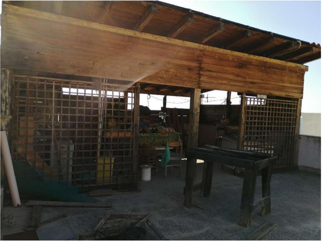
Foto n° 70 Tettoia al piano 2 e parziali chiusure laterali
