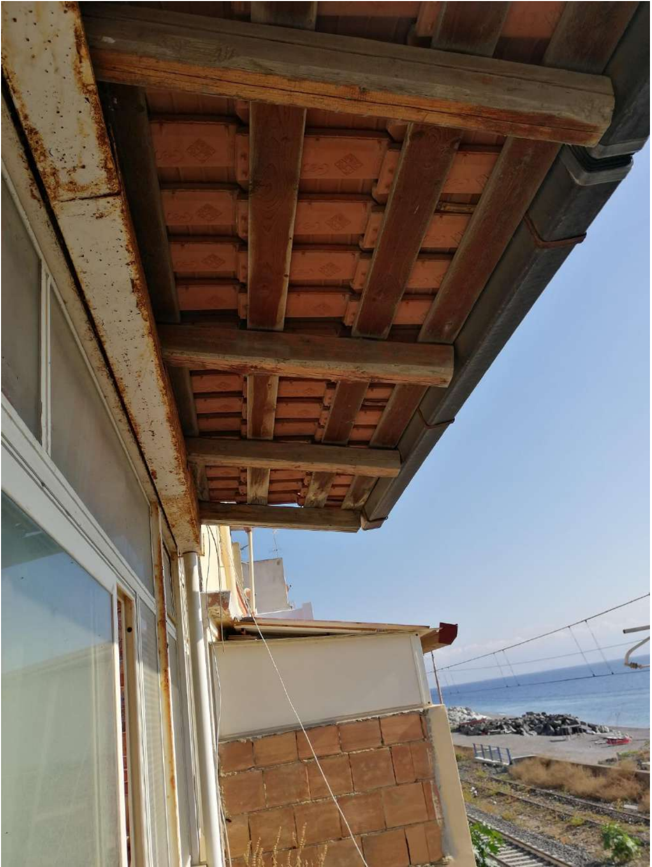
Foto n° 58 Altra veduta della pensilina sul lato sud est
