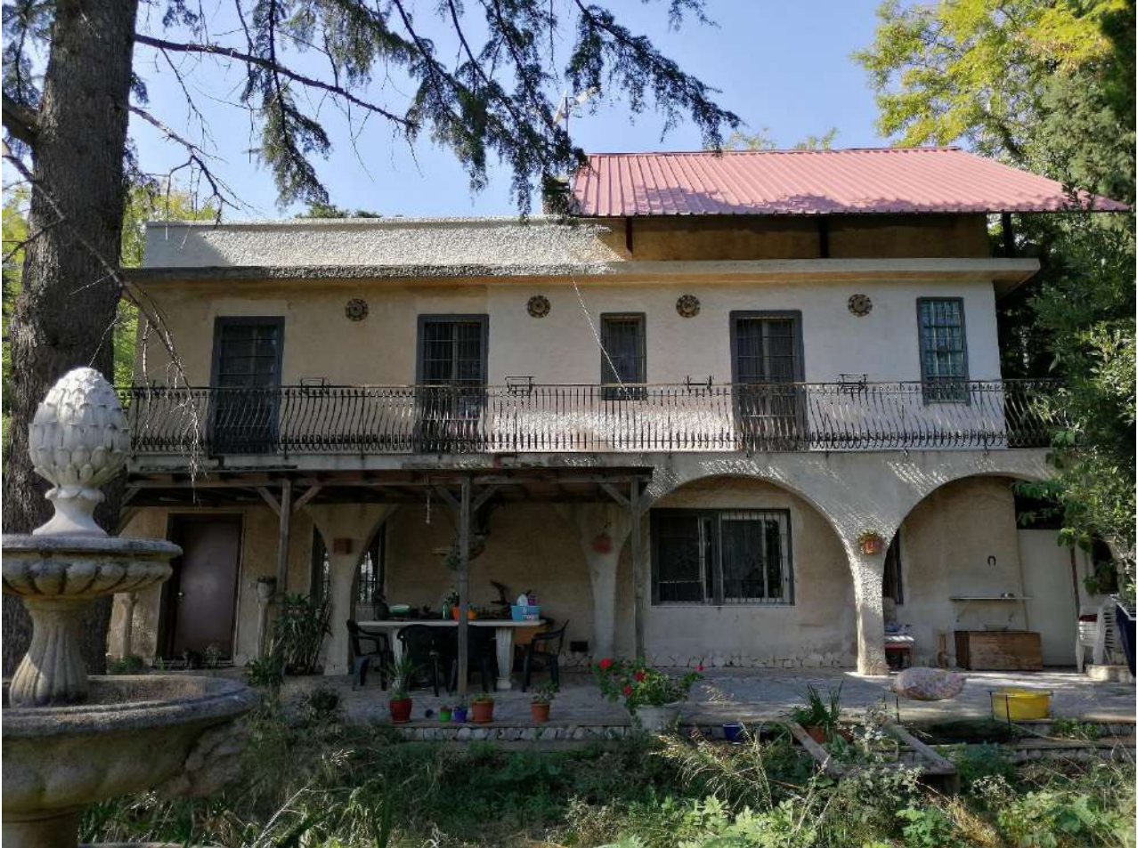
Foto n° 1 Il fabbricato oggetto di accertamento – Prospetto principale
