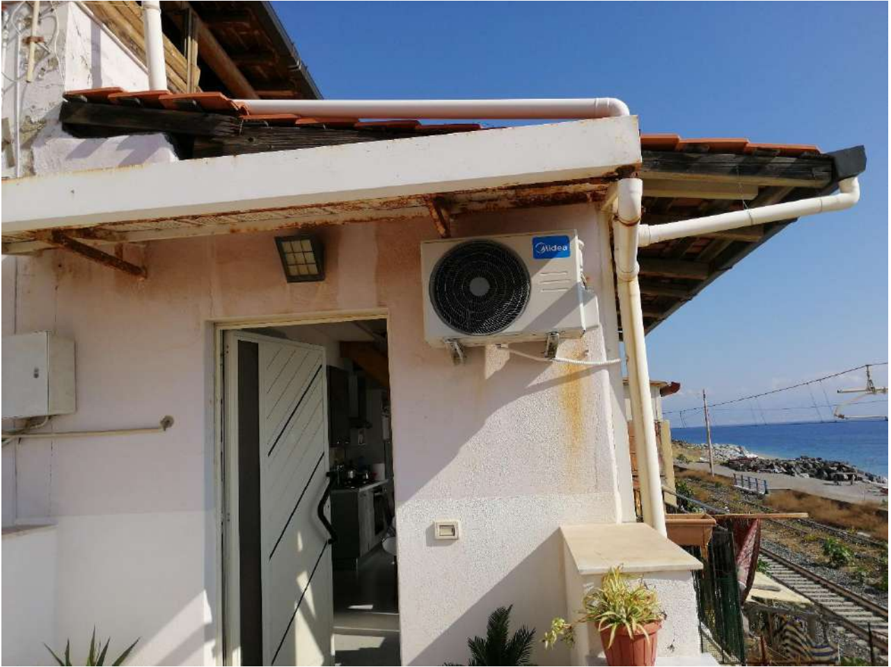
Foto n° 59 Prospetto laterale e zona di ingresso
