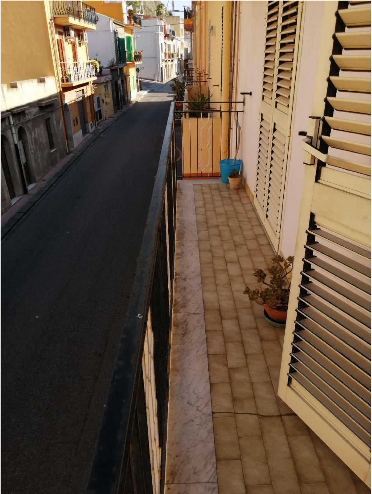
Foto n° 69 Balcone su Via Roma
