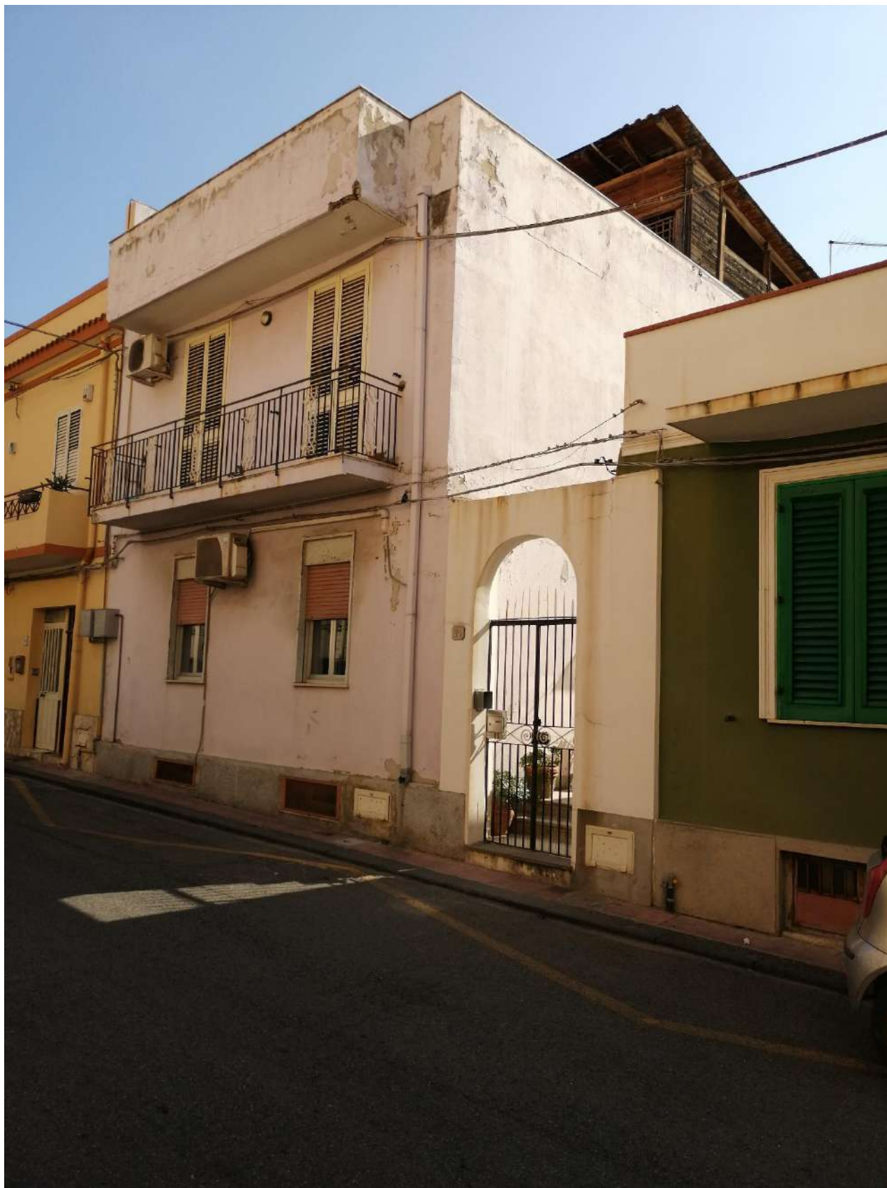
Foto n° 53 Fabbricato in Scaletta dove ricade l'appartamento a piano 1 e 2
