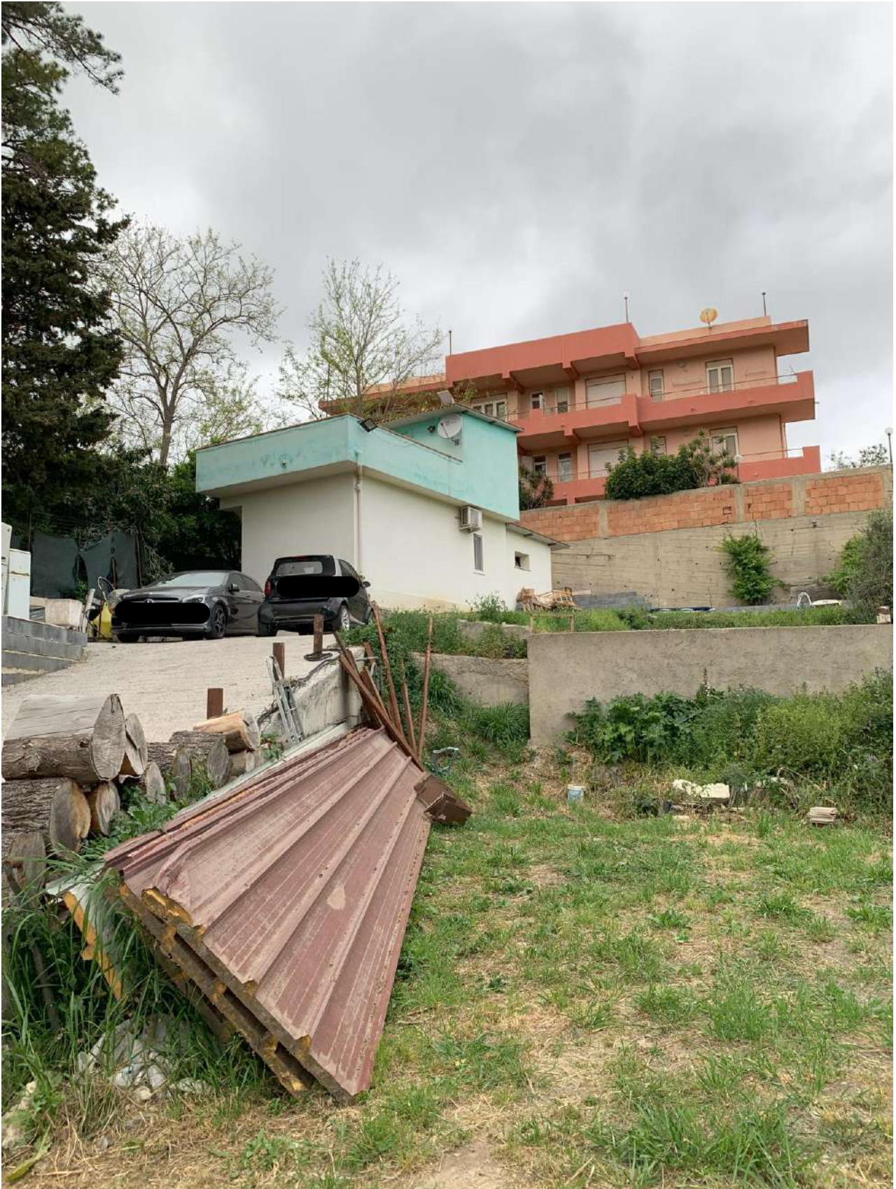
Foto n° 52 Veduta del fabbricato (part. 500) da terreno non interessato dalla procedura esecutiva
