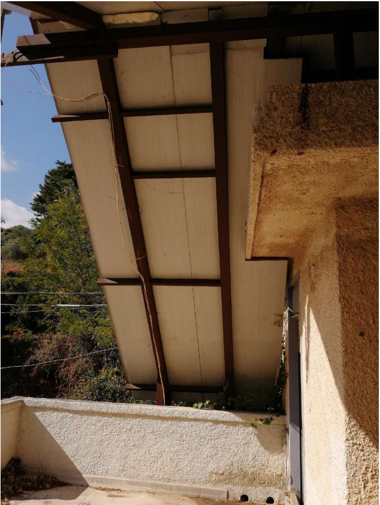
Foto n° 29 Particolare della copertura e dello stato manutentivo del manto e dei parapetti
