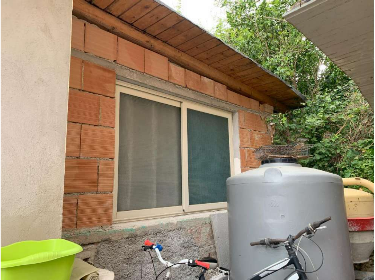
Foto n° 42 Manufatto in muratura in ampliamento al fabbricato originario (part. 500)
