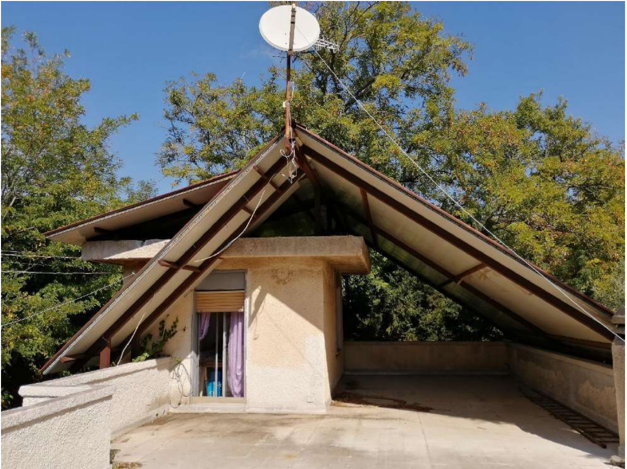
Foto n° 27 La terrazza e la struttura di copertura
