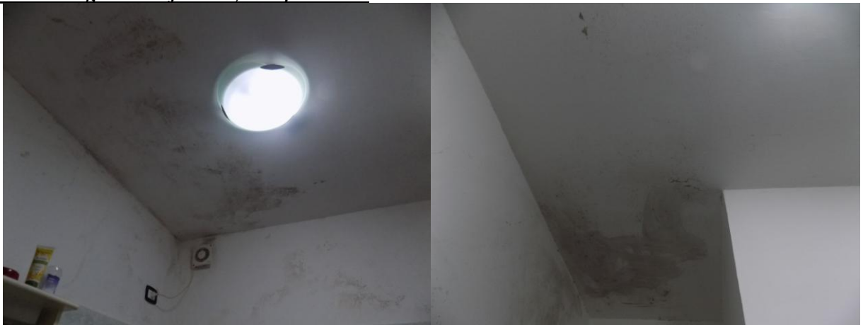
Rilievo fotografico CTU del 29.05.2025: Bagno-Lavanderia di servizio con doccia e lavabo, privo di aperture . Lo stesso risulta essere stato interessato da fenomeni di umidità derivanti da perdite dal livello superiore , tuttavia, all'attualità le cause risulterebbero state rimosse, sussistendo comunque i danni emergenti alle finiture, da ripristinare.
