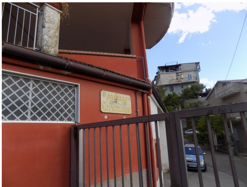
Rilievo fotografico CTU del 29.05.2025: Cancello d'Ingresso Condominiale , a Palazzo Rossomando di Via Acquolella civ.2 in Frazione Martorani del Centro Capoluogo di Montecorvino Rovella.
