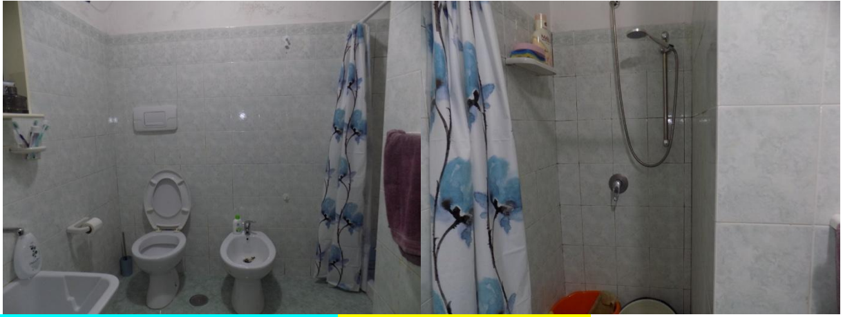
Rilievo fotografico CTU del 29.05.2025: Bagno-Lavanderia di servizio con doccia e lavabo, privo di aperture . Lo stesso risulta essere stato interessato da fenomeni di umidità derivanti da perdite dal livello superiore , tuttavia, all'attualità le cause risulterebbero state rimosse, sussistendo comunque i danni emergenti alle finiture, da ripristinare.
