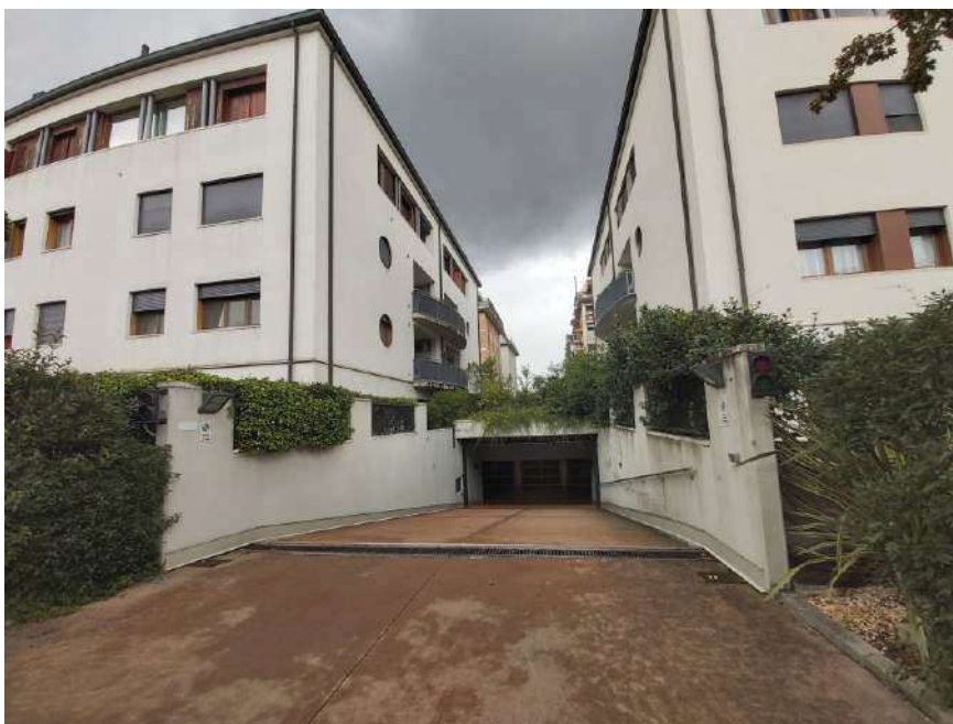
Accesso carraio da via Generale Emanuele del Prà
