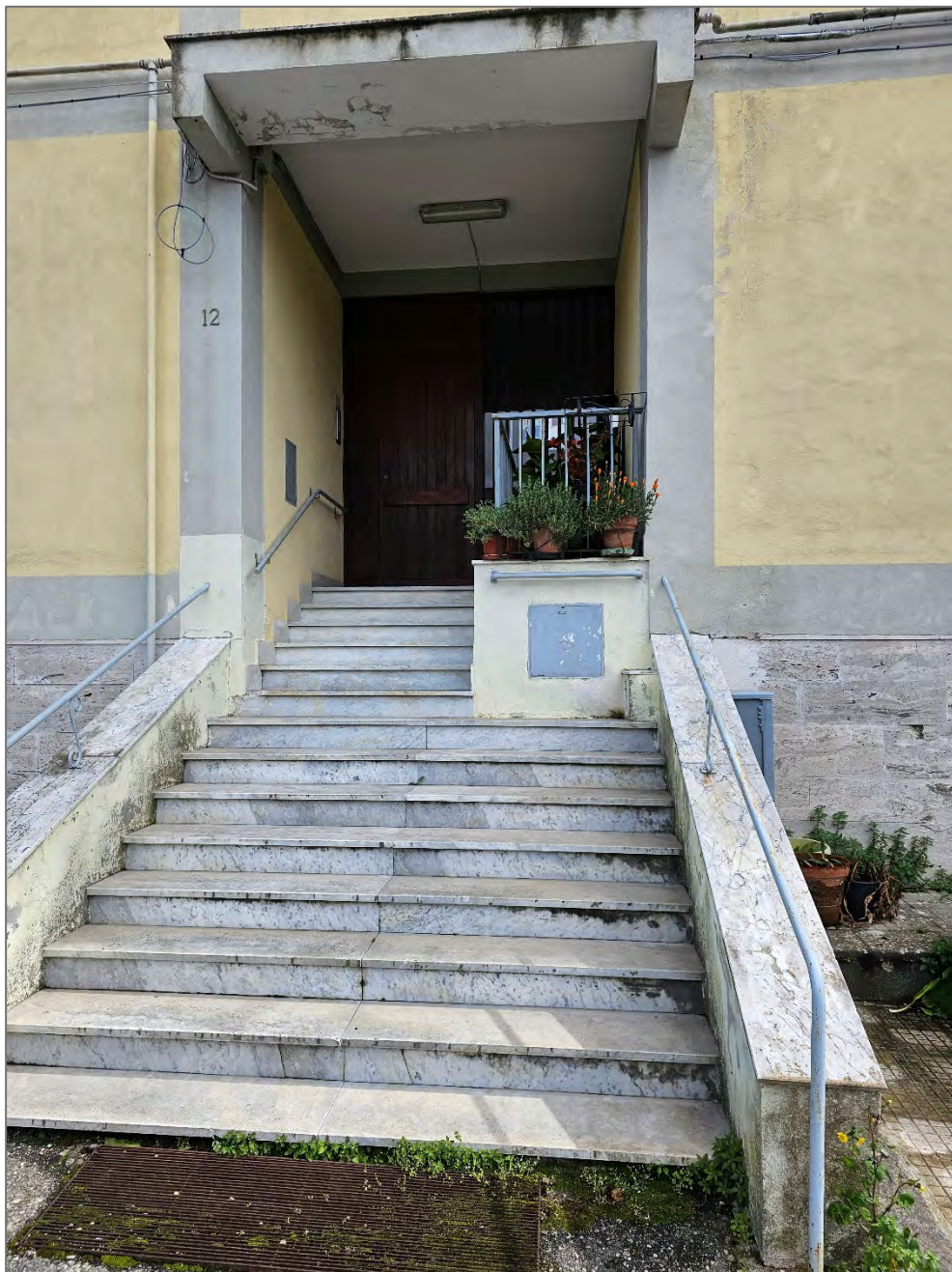
Foto 3, 4 – Ingresso la Fabbricato e al bene oggetto di pignoramento
