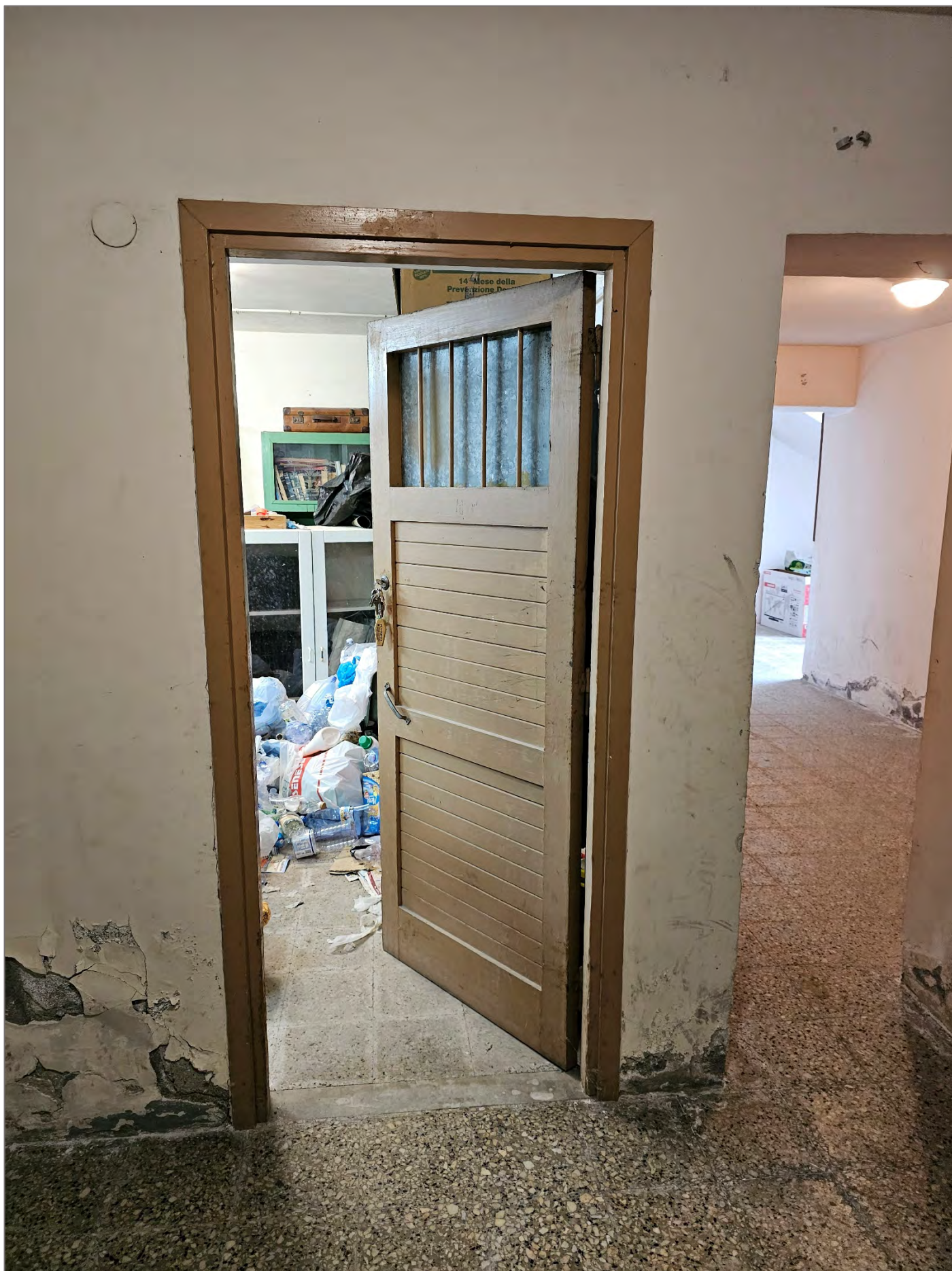
Foto 31 – Portoncino di ingresso cantina posta al primo piano sottostrada
