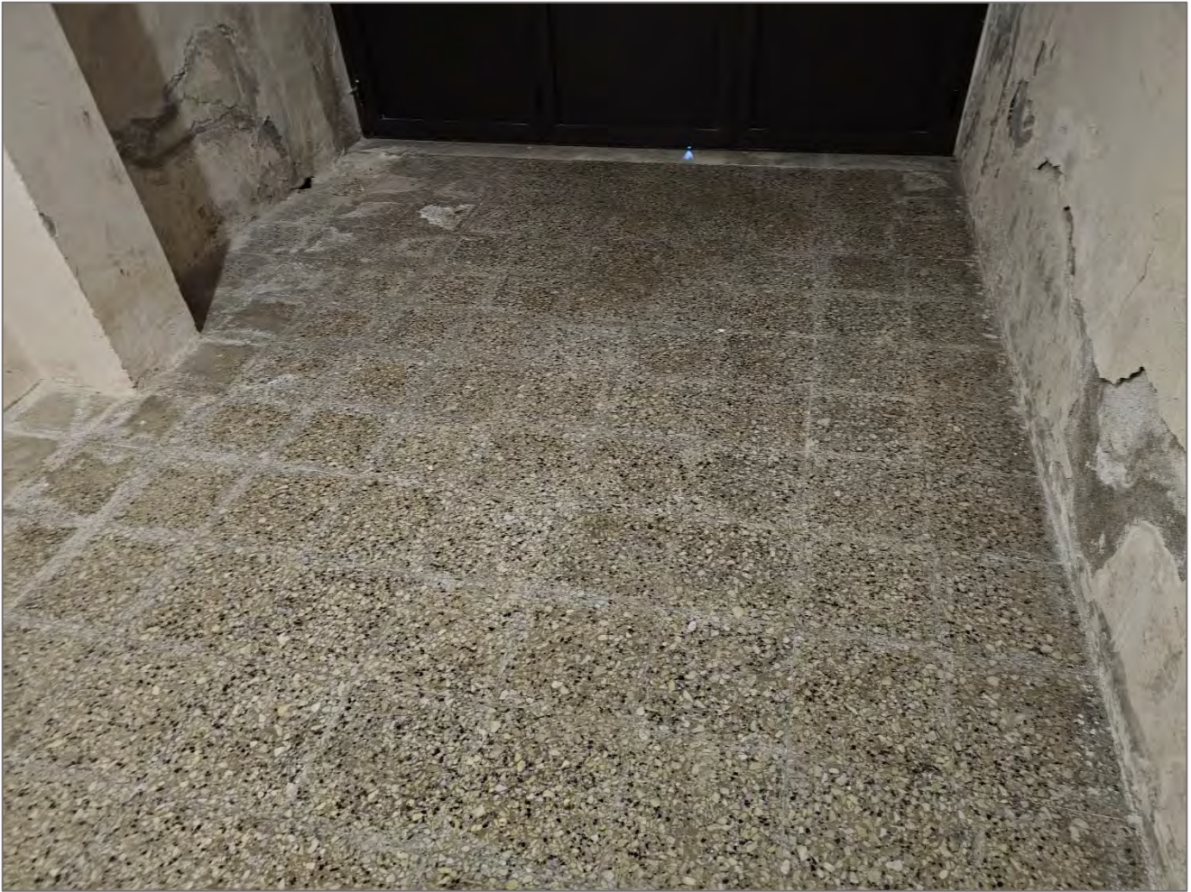
Foto 34, 35 –Stato murature dello spazio condominiale adiacente la cantina oggetto di pignoramento. Ingresso esterno cantina
