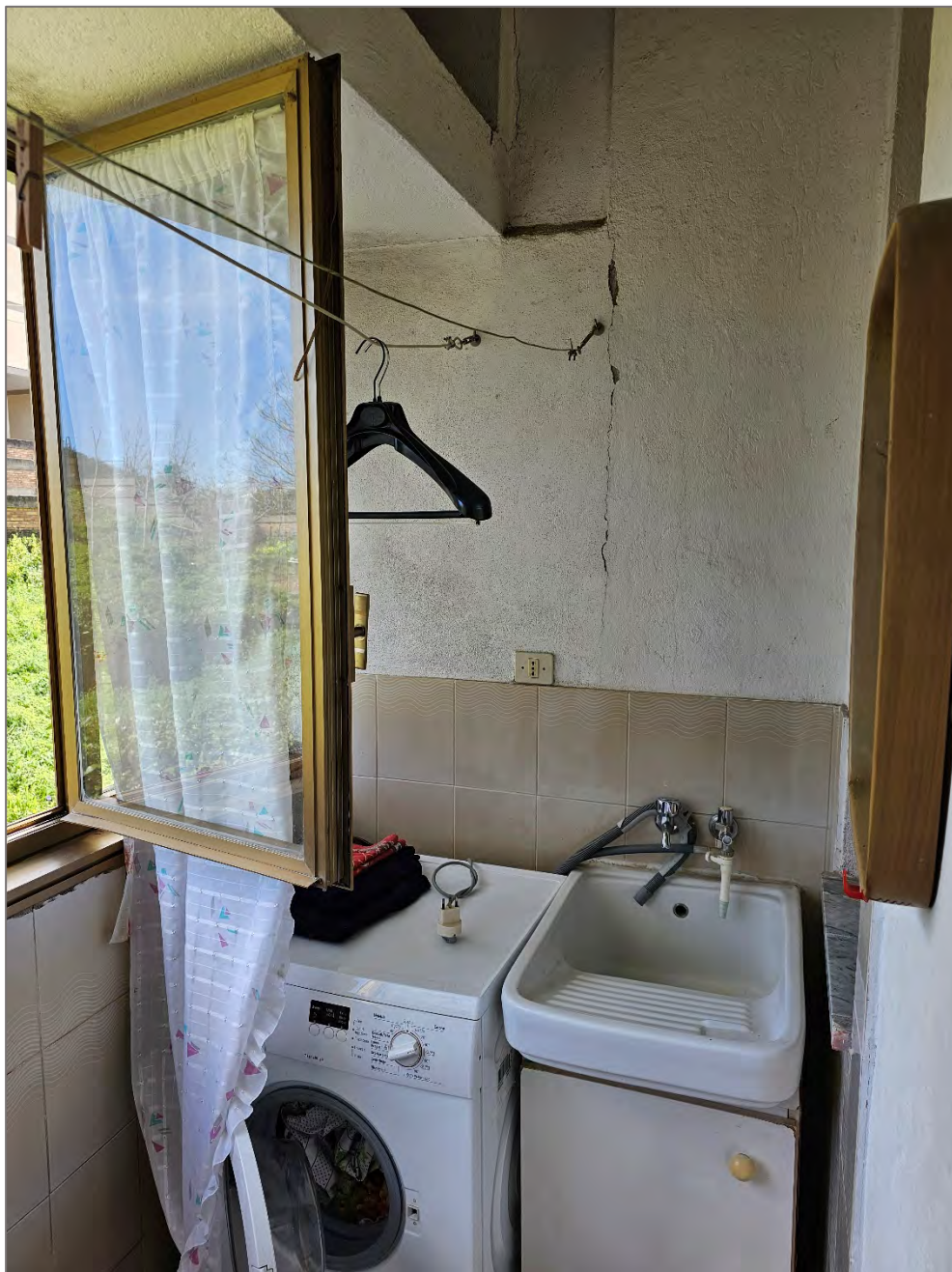
Foto 29, 30 –Veranda posta sul prospetto tergale dell’abitazione
