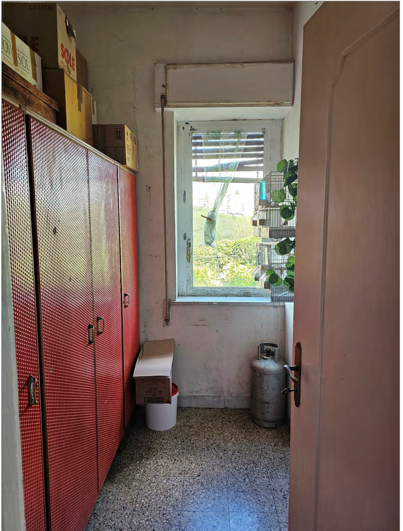
Foto 19 – Ripostiglio unità immobiliare posto tra le due stanze da letto.
