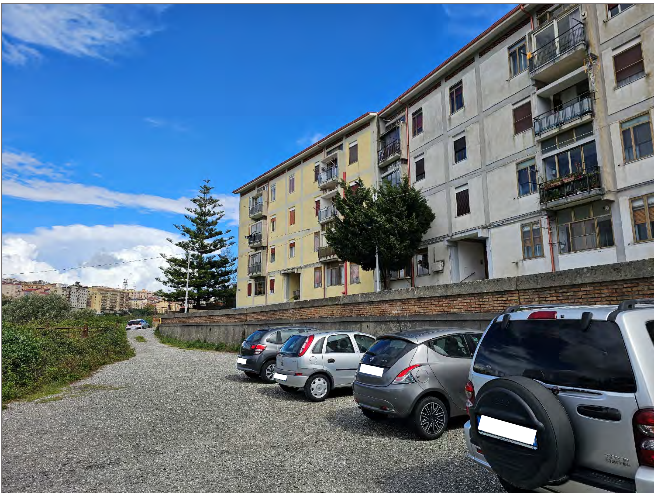
Foto 1, 2 – Fabbricato dove è posto il bene oggetto di pignoramento
