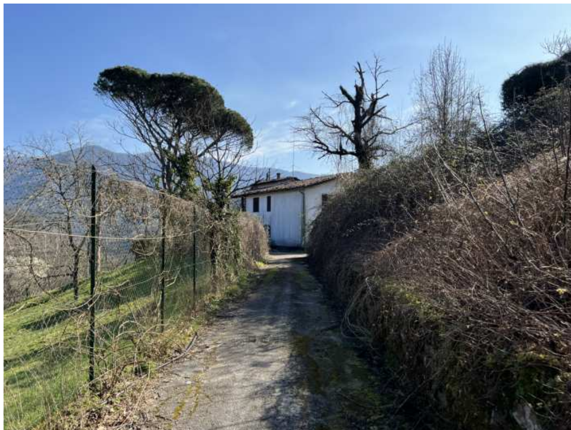
Descrizione: Vista del fabbricato e della strada di accesso su terreno di pertinenza.
