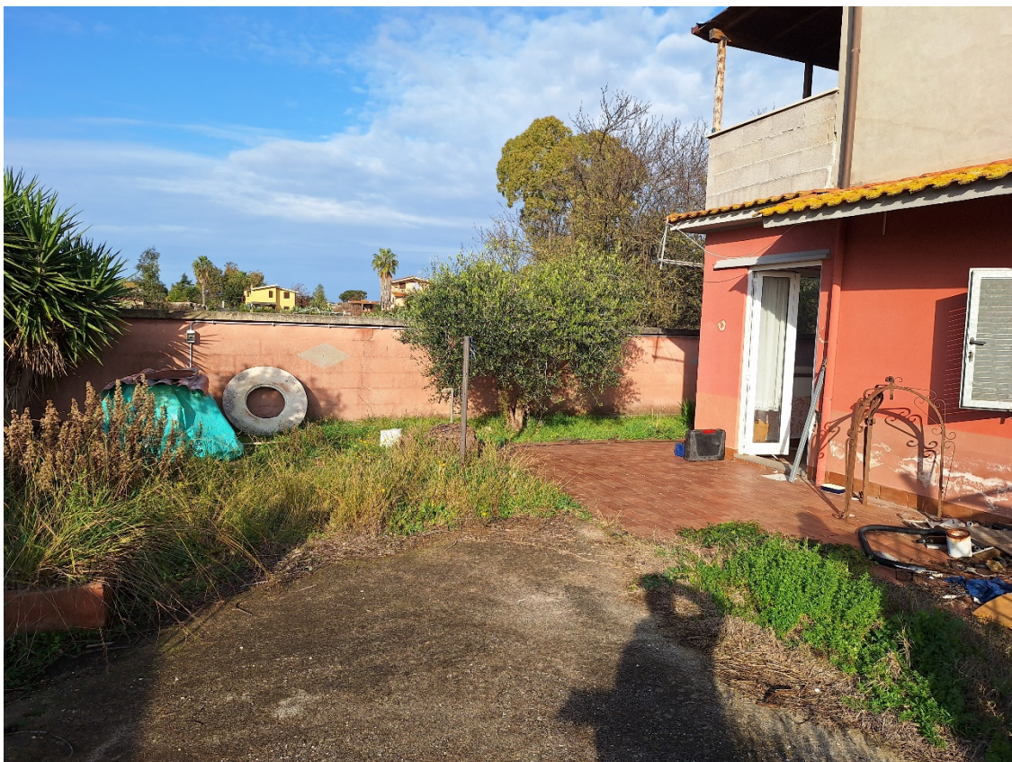
Foto 4 – Vista esterna ingresso – giardino
