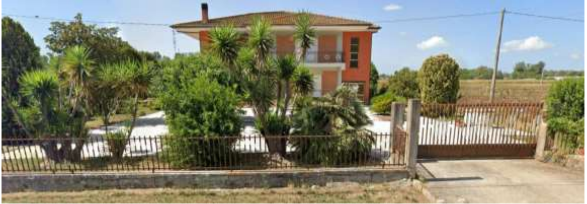
Figura 5 Vista frontale di uno degli accessi al Bene 1
