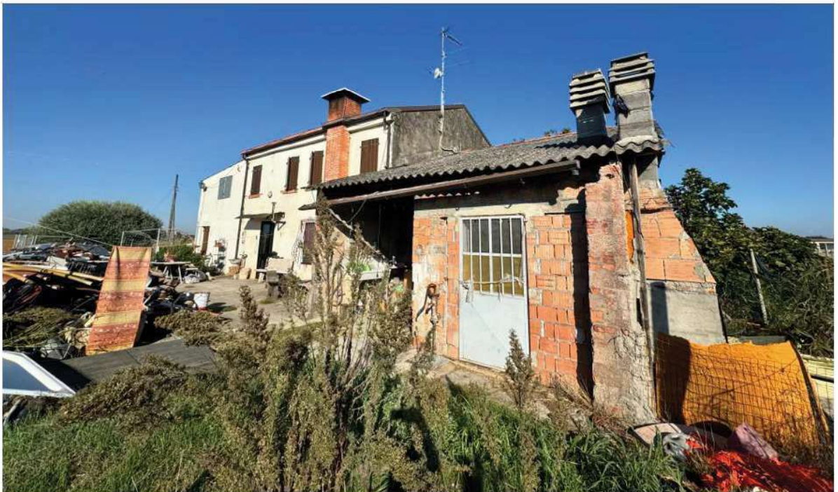
FOTO 4 - Fronte sud-ovest 1.a
