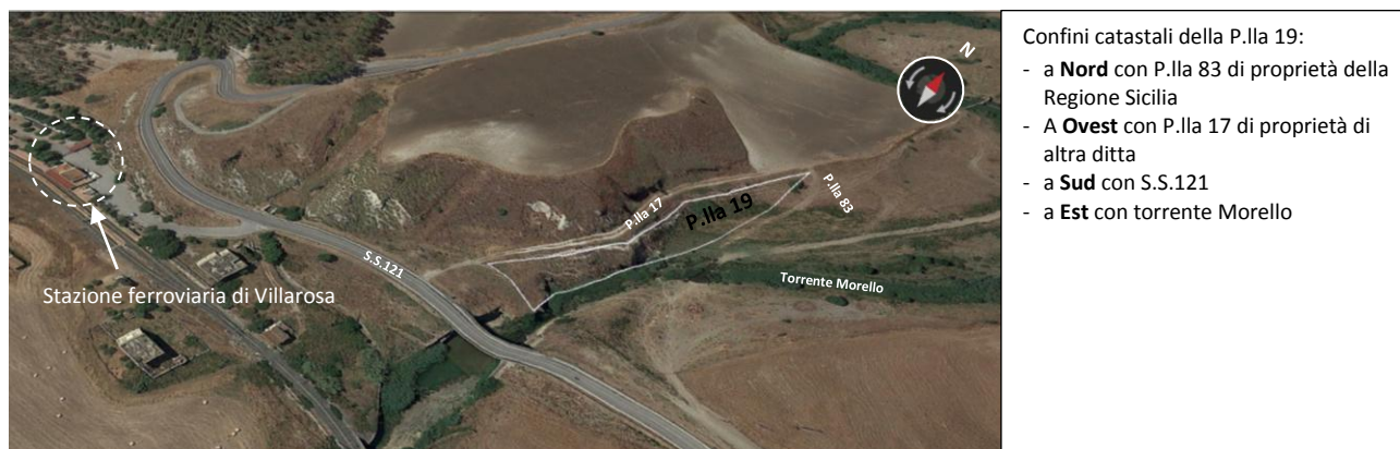
Img.3 : Stralcio aerofotogrammetrico, estratto dai servizi di Google Maps con indicazione del bene immobile oggetto di procedimento (retino in Bianco) e delle p.lla ad esso confinanti
