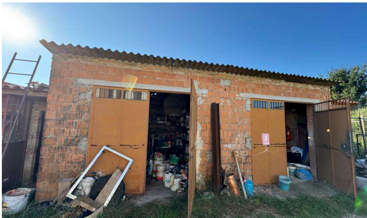
FOTO 6 - Fronte nord 1.b
