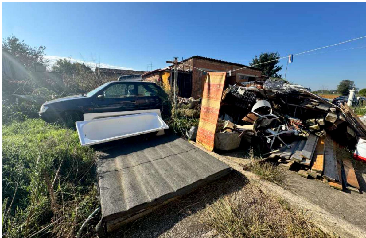
FOTO 5 - Fronte nord 1.b
