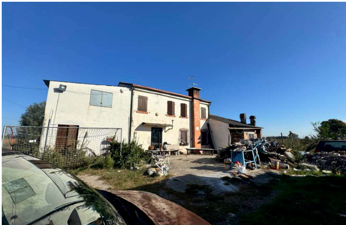
FOTO 3 - Fronte sud 1.a
