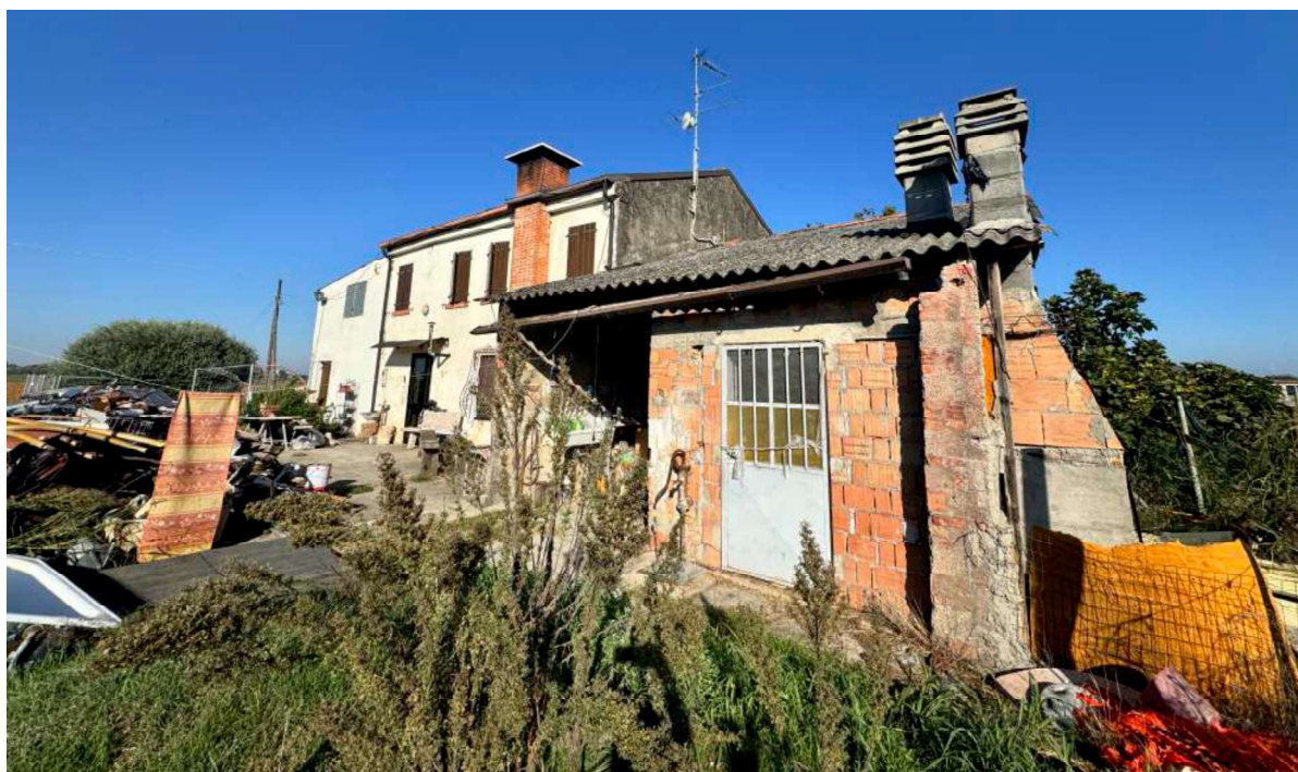
FOTO 4 - Fronte sud-ovest 1.a
