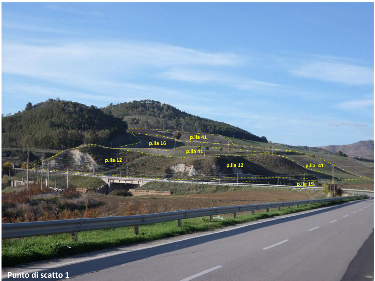
FOTO N°1: Vista in direzione N-O degli IMMOBILI 1,2,3 e 4 , identificati catastalmente al F.43, P.lle 12,16,19 e 41 (si veda linea in tratteggio gialla e posizione punto di scatto indicata nell'immagine superiore)
