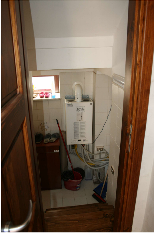
12 e 13 | Piano terra: bagno sottoscala
