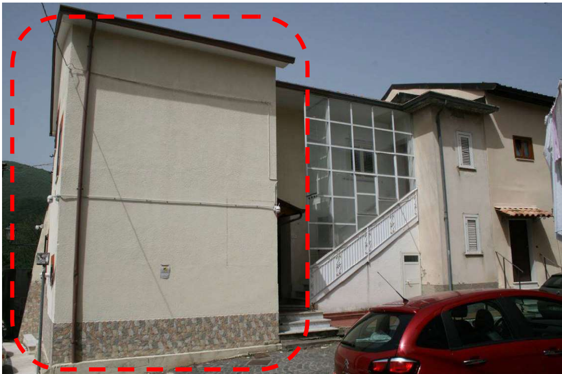
4 | Prospetto Est del fabbricato, con evidenziata l'unità pignorata
