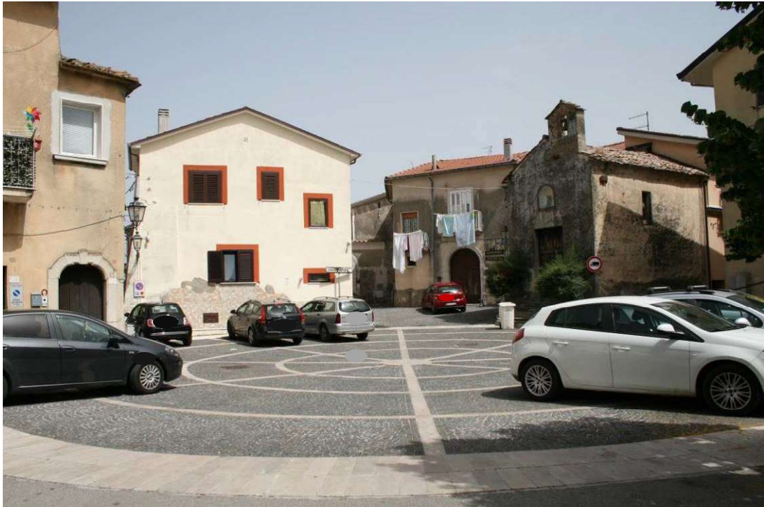
3 | Prospetto Sud del fabbricato
