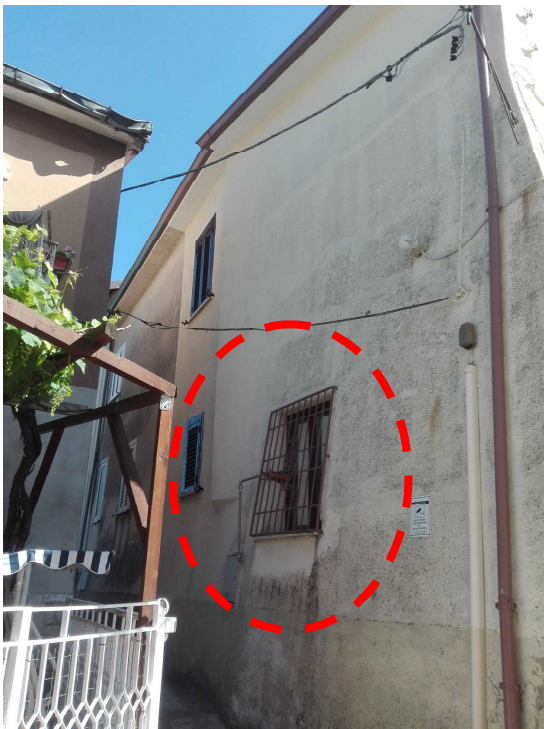
6 e 7 | Prospetto Sud - Ovest del fabbricato In evidenza la finestra murata all'interno
