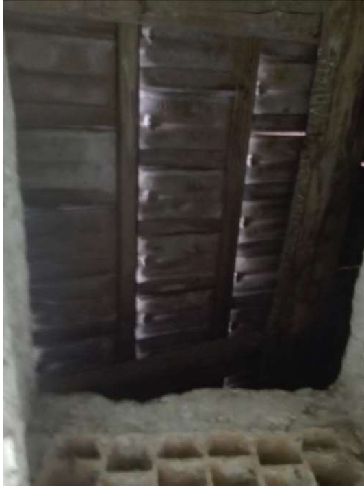
23 | Sottotetto: particole copertura in legno e tegole
