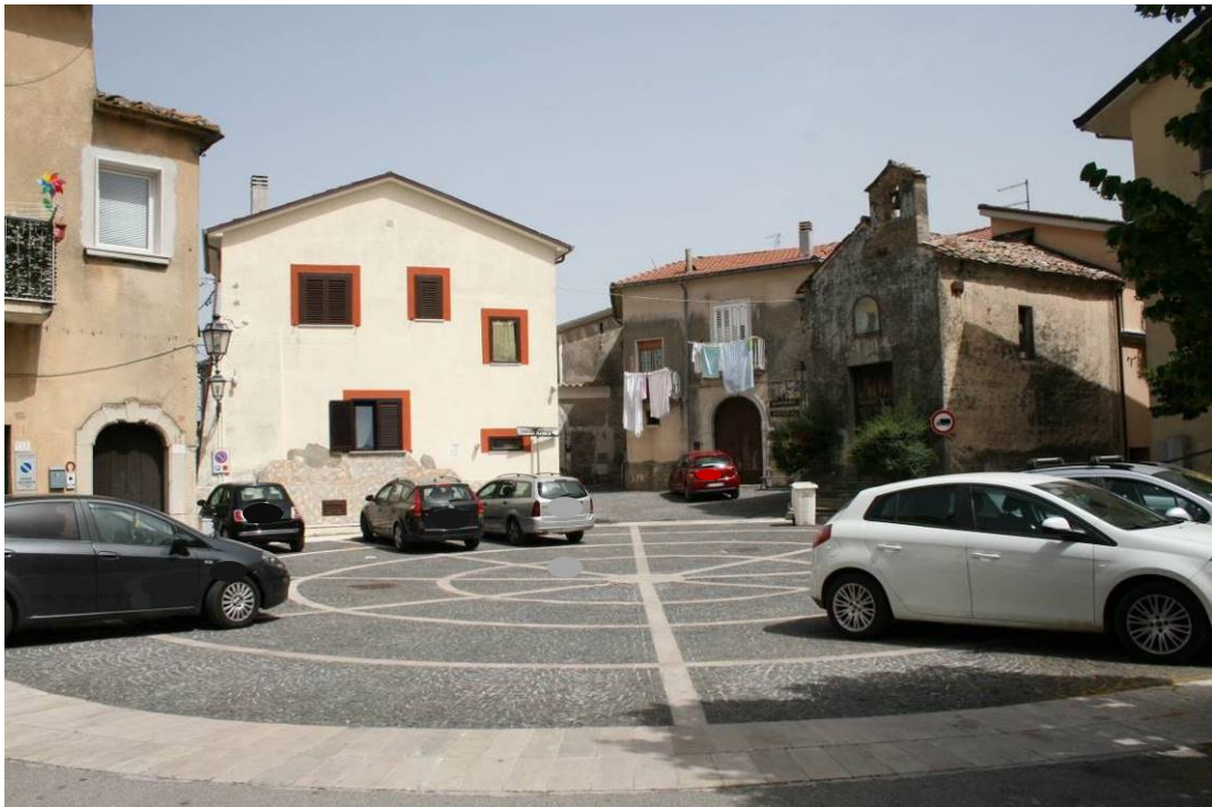
3 | Prospetto Sud del fabbricato
