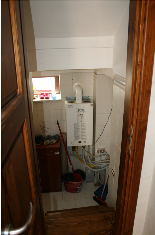
12 e 13 | Piano terra: bagno sottoscala
