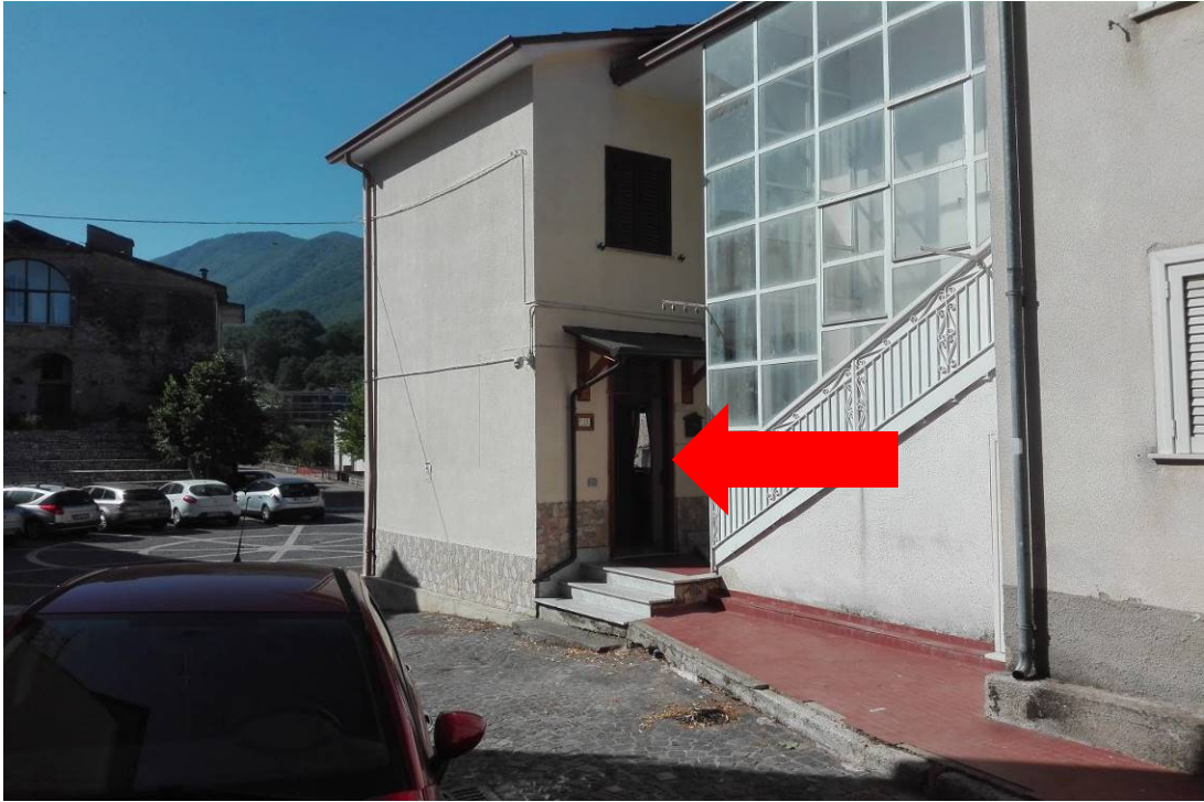
5 | Prospetto Est del fabbricato | Accesso unità pignorata
