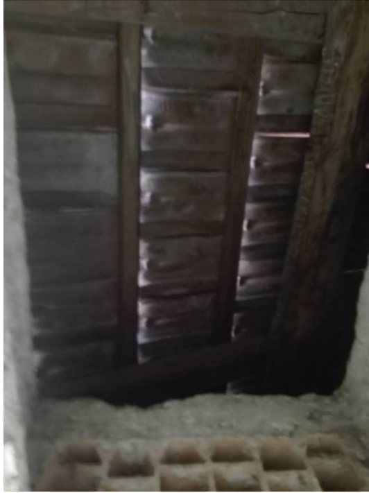
23 | Sottotetto: particole copertura in legno e tegole
