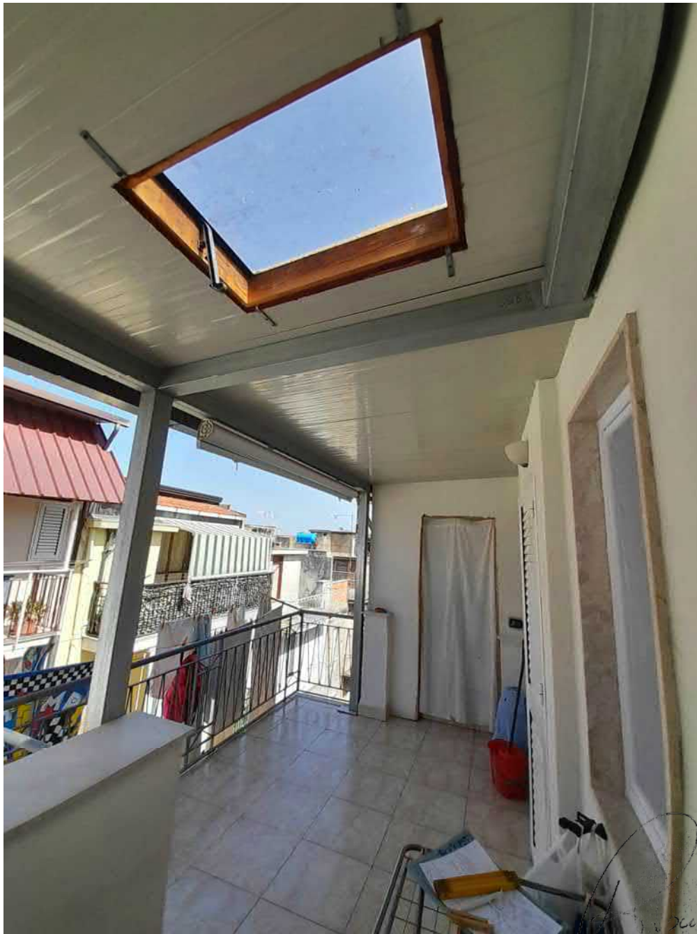
Foto n°11 - Vista della veranda coperta al 3° piano
