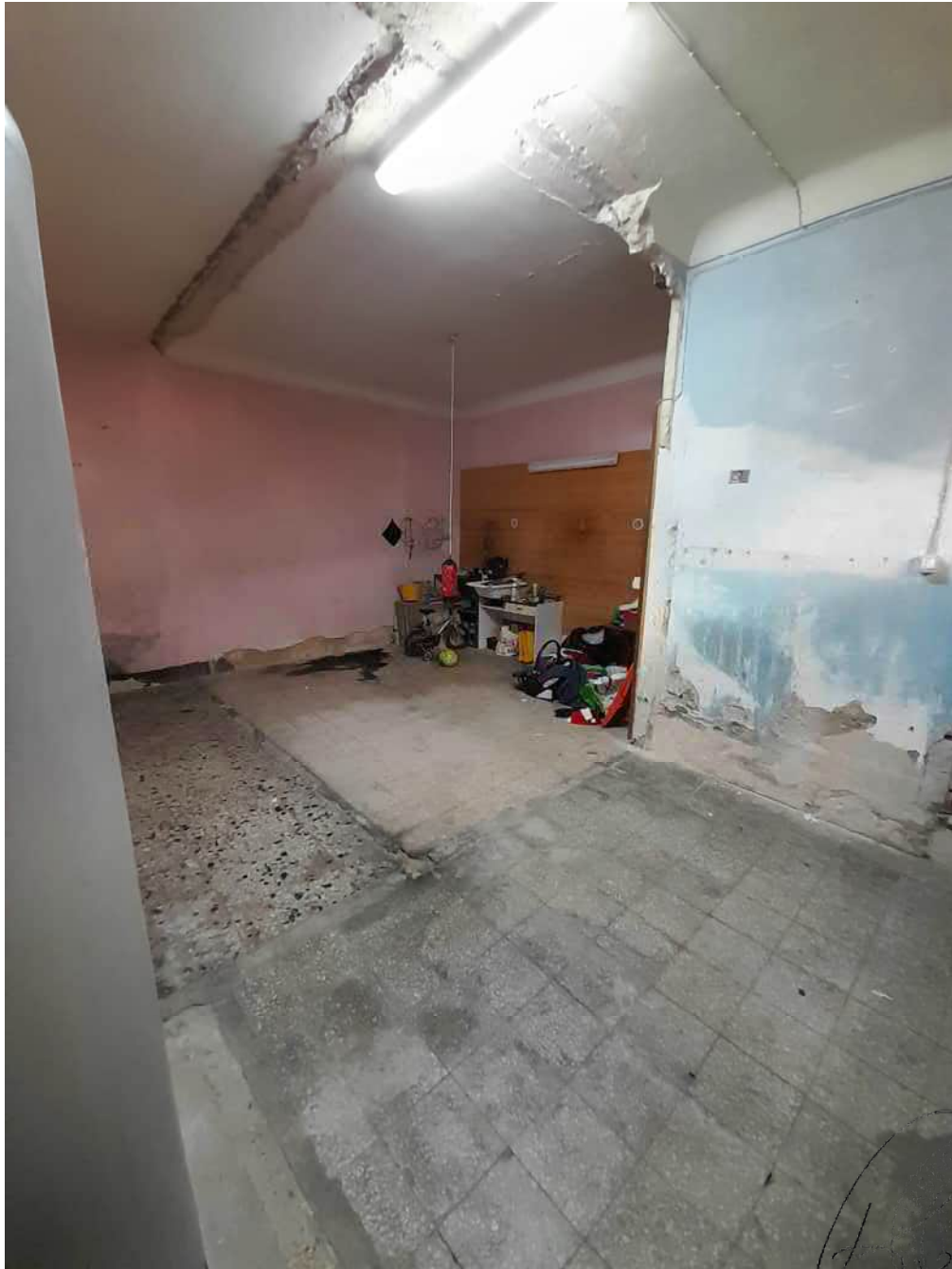
Foto n°15 - Vista interna dell'autorimessa
