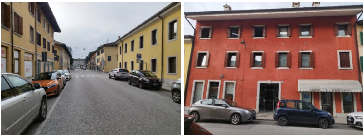
Vista Borgo Aquileia e Prospetto principale fabbricato con ingresso galleria
