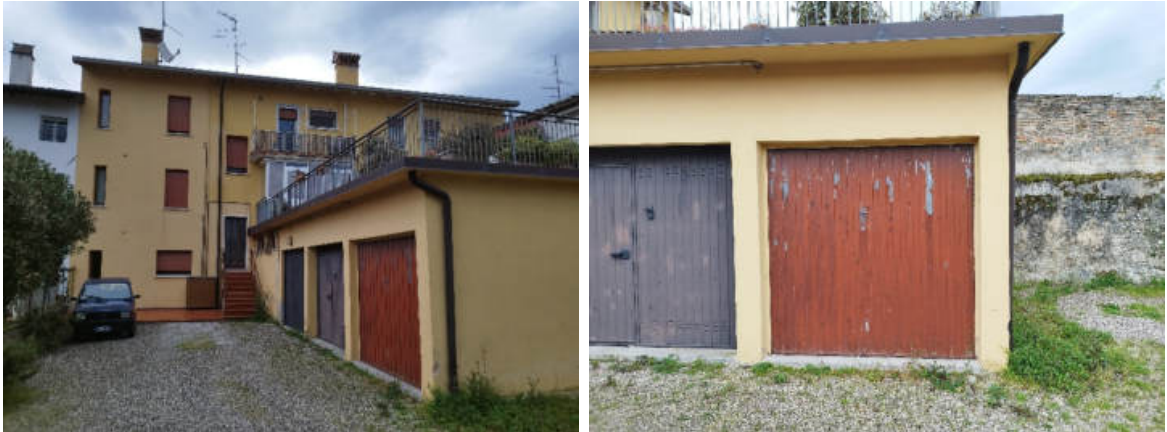
Prospetto lato corte interna e vista fabbricato autorimesse
