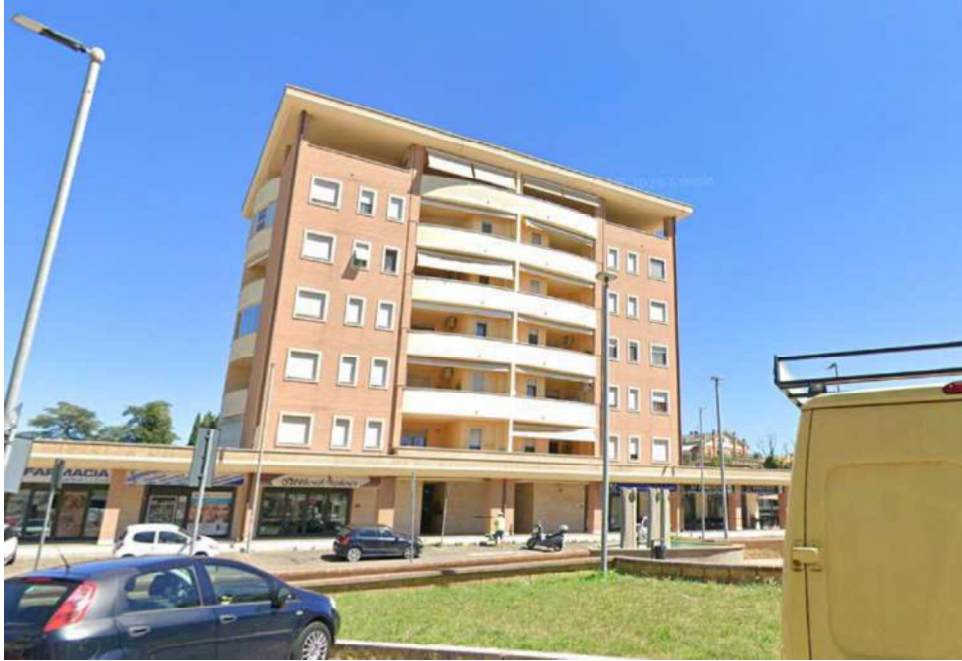
FOTO 1 - Edificio in via Santa Maria Teresa di Calcutta n° 12
