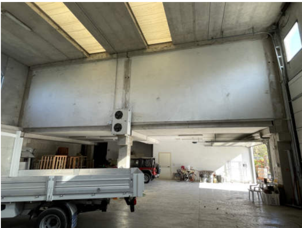
Foto n.06 (deposito piano terra)
