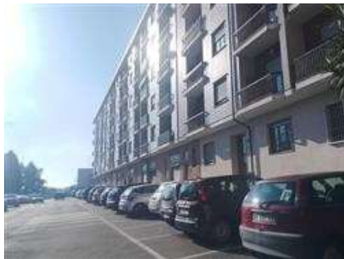
vista del condominio
