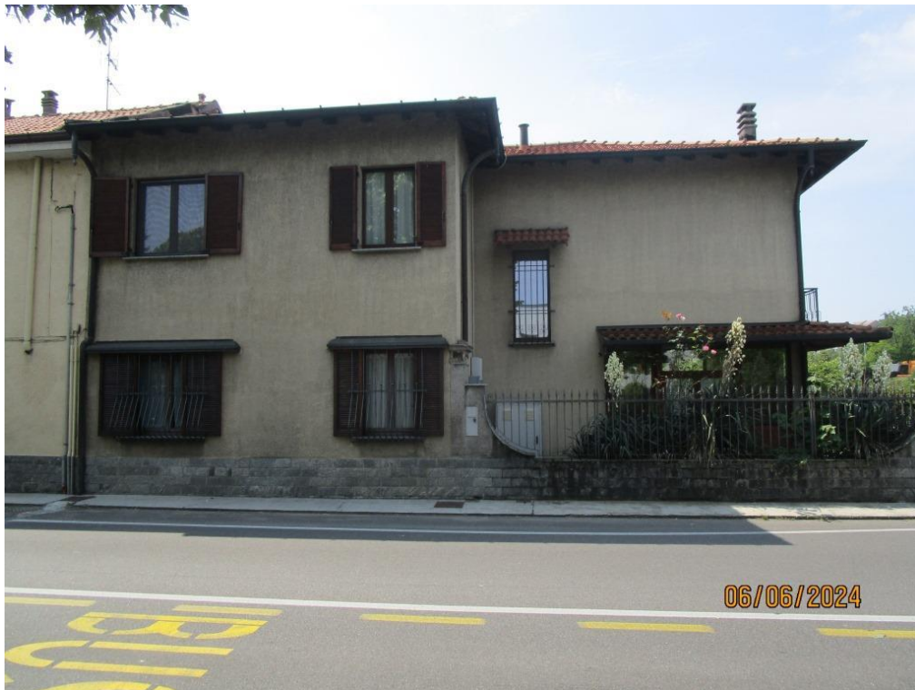
Foto 1 – Vista del fabbricato residenziale da via Marconi
