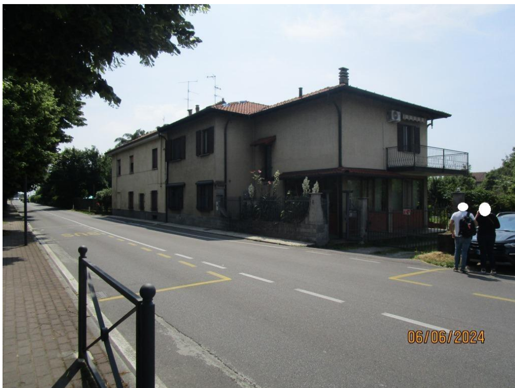
Foto 2 – Vista del fabbricato residenziale da via Marconi
