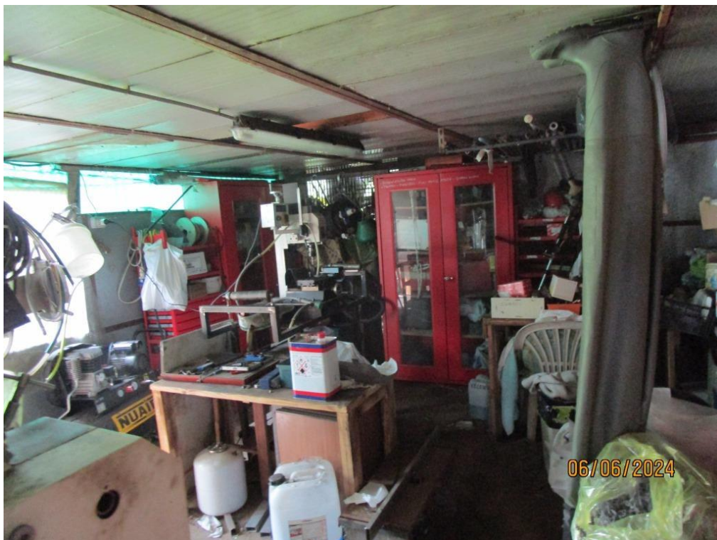
Foto 59 – Porzione di autorimessa realizzata in ampliamento senza concessioni
