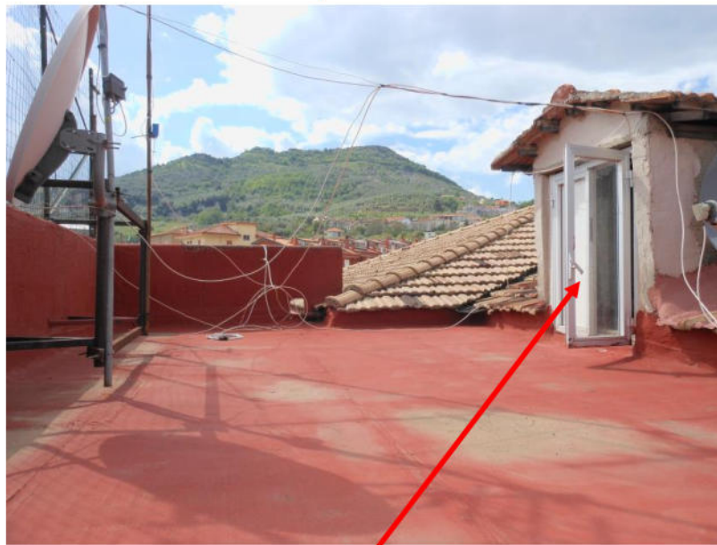
Ingresso comune al piano terzo sottotetto FOTO 23 – Botola di accesso all'area comune
