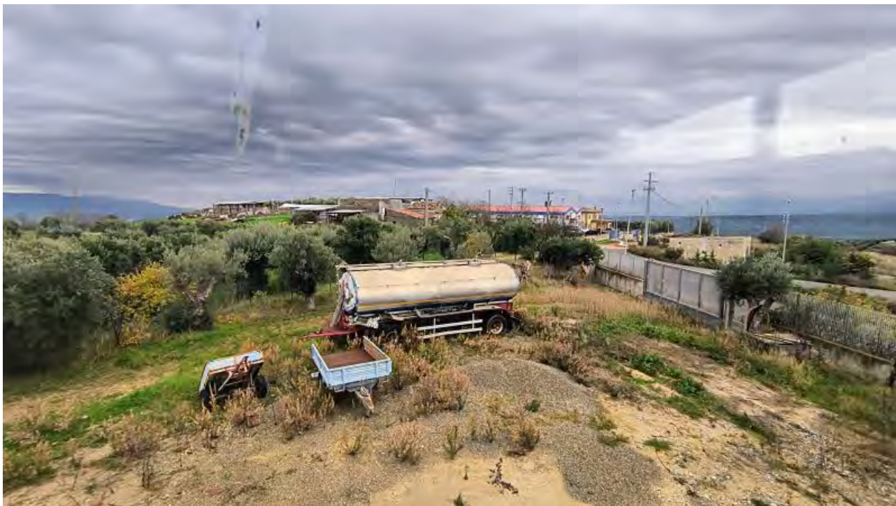
Foto 49 - Area esterna lato Est con mezzi e attrezzature residui.
