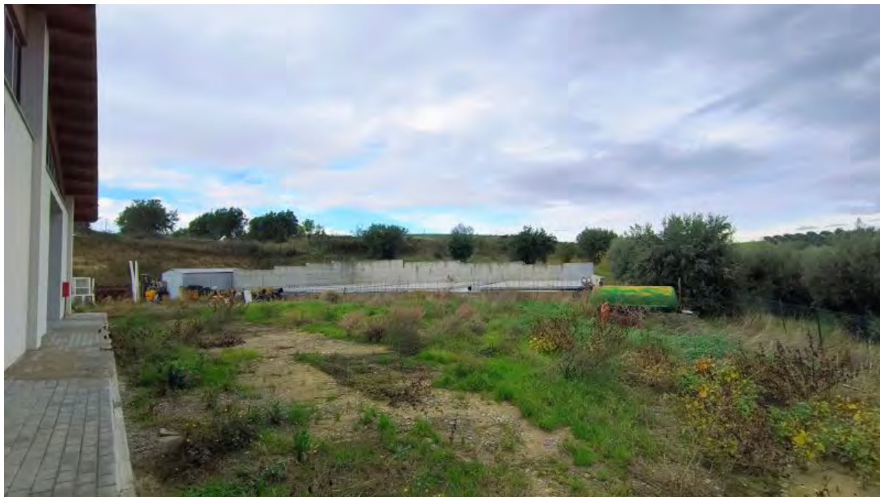
Foto 51 - Area esterna posteriore lato Nord.
