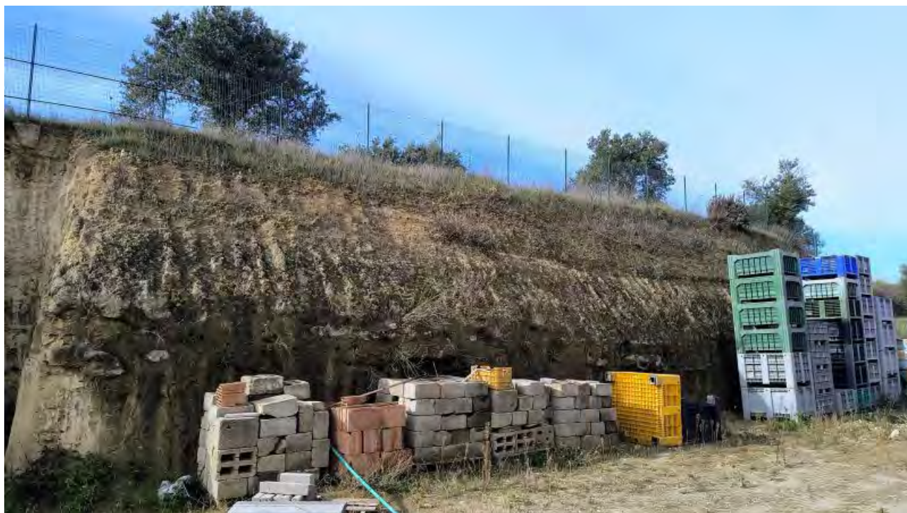
Foto 55 - Recinzione in rete e paletti lato Ovest.
