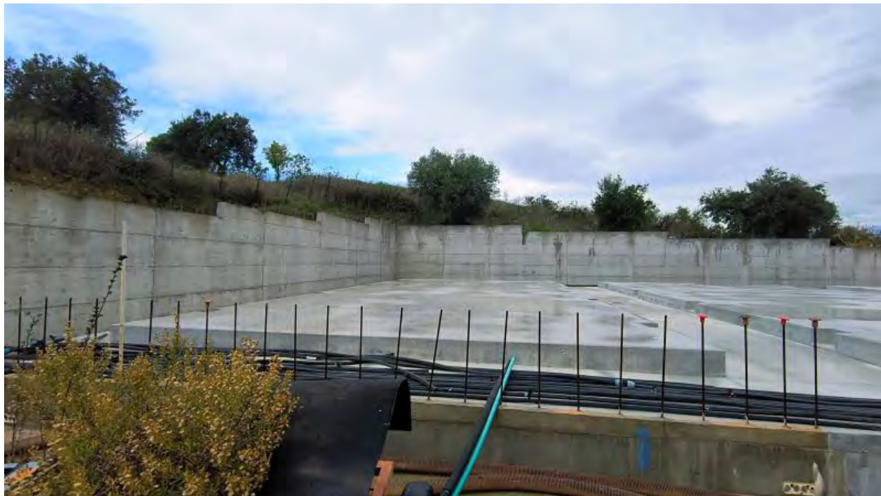
Foto 62 - Platea in c.a. basamento silos stoccaggio lato Nord.
