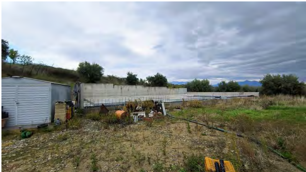
Foto 61 - Platea in c.a. basamento silos stoccaggio lato Nord.
