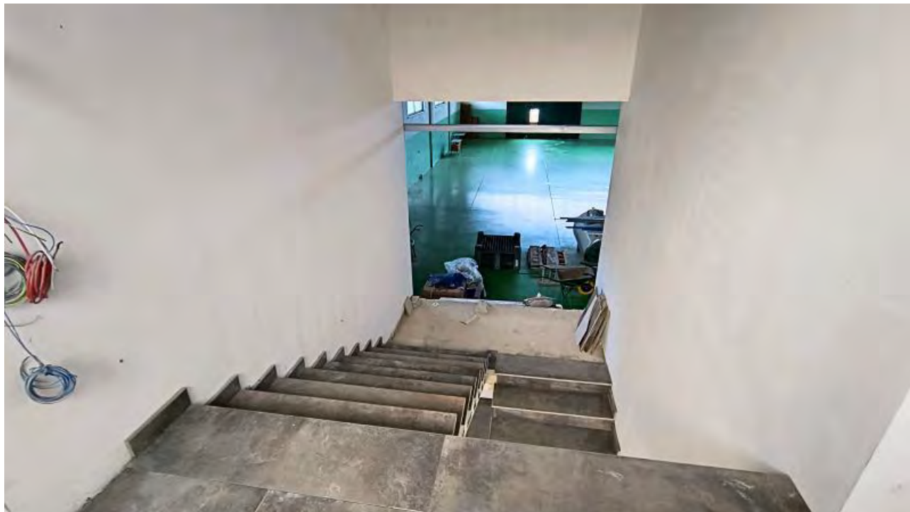
Foto 32 - Edificio uffici e servizi, piano primo, vano scala ala Ovest.
