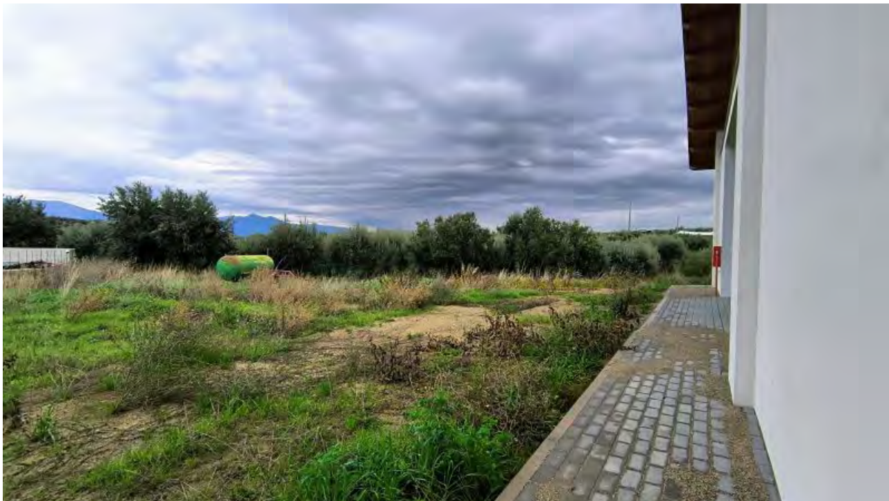
Foto 50 - Area esterna posteriore lato Nord.
