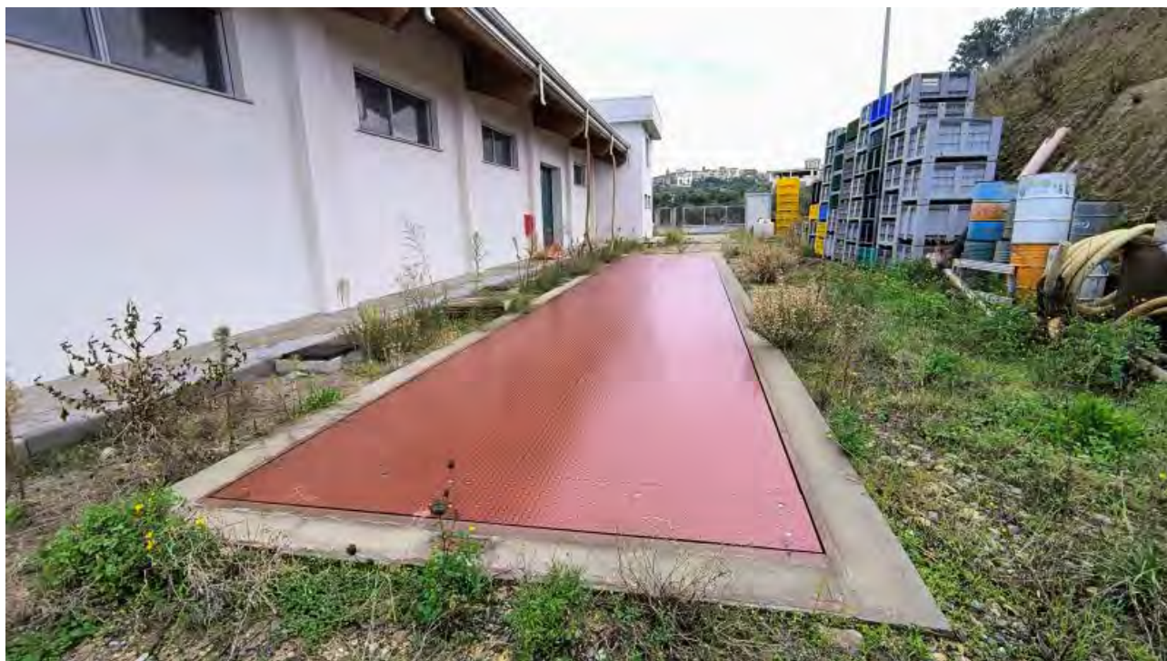
Foto 57 - Pesa a ponte lato Ovest capannone.
