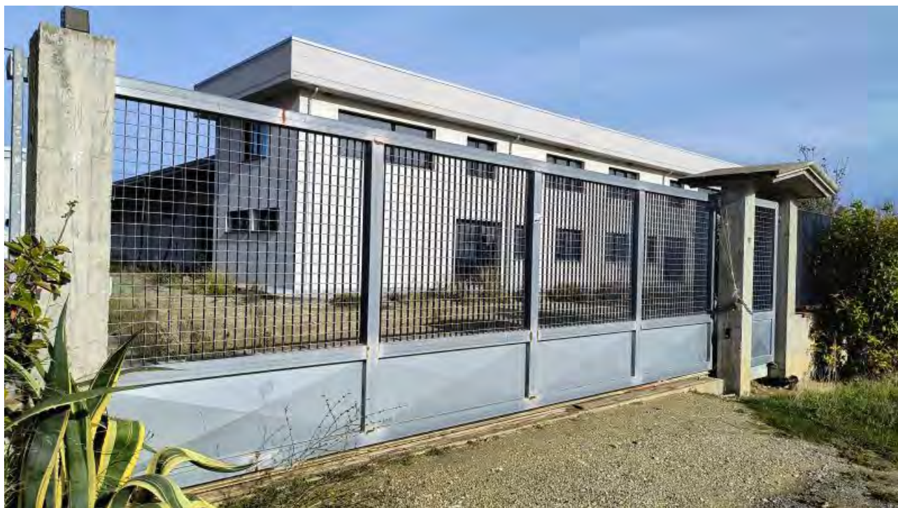
Foto 53 - Cancello esterno Ovest.
