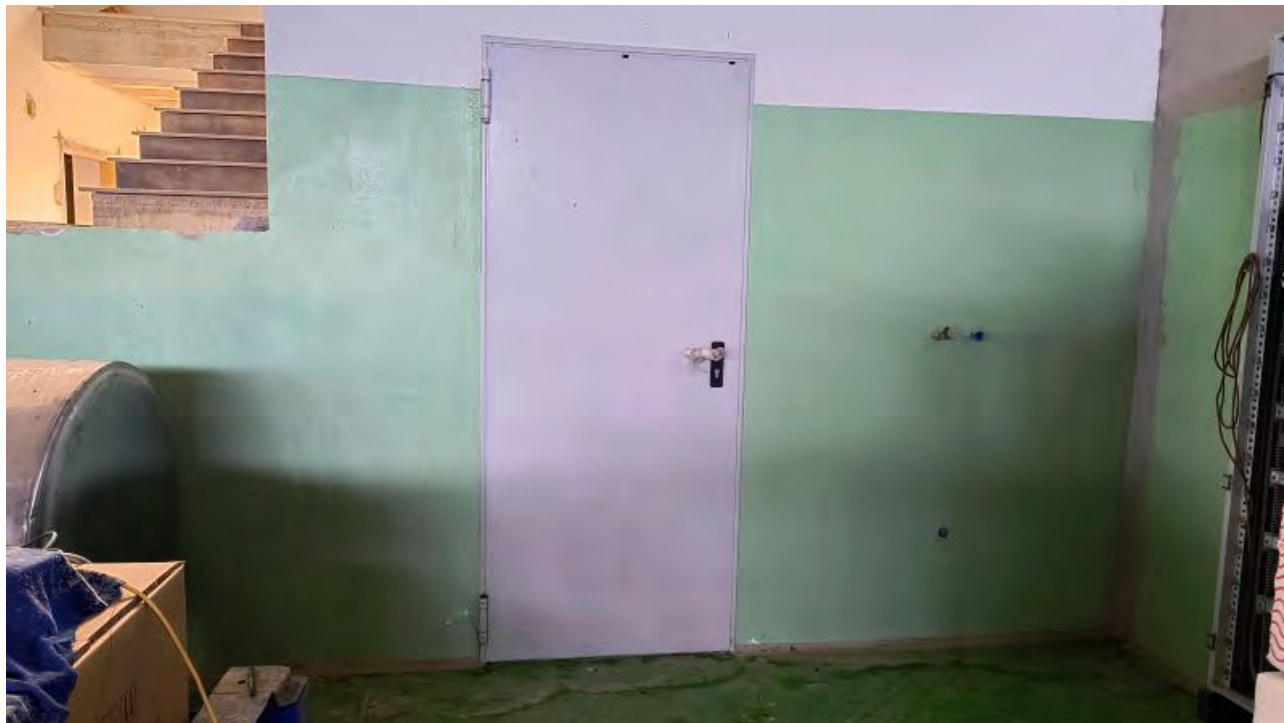
Foto 16 - Porta di comunicazione capannone produttivo con edificio uffici e servizi.
