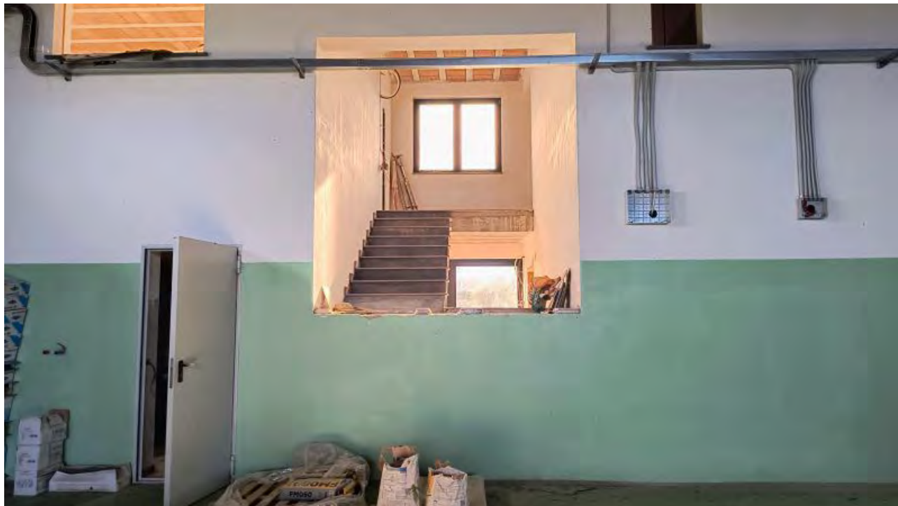
Foto 42 - Vano scala edificio uffici e servizi aperto ala Est.
