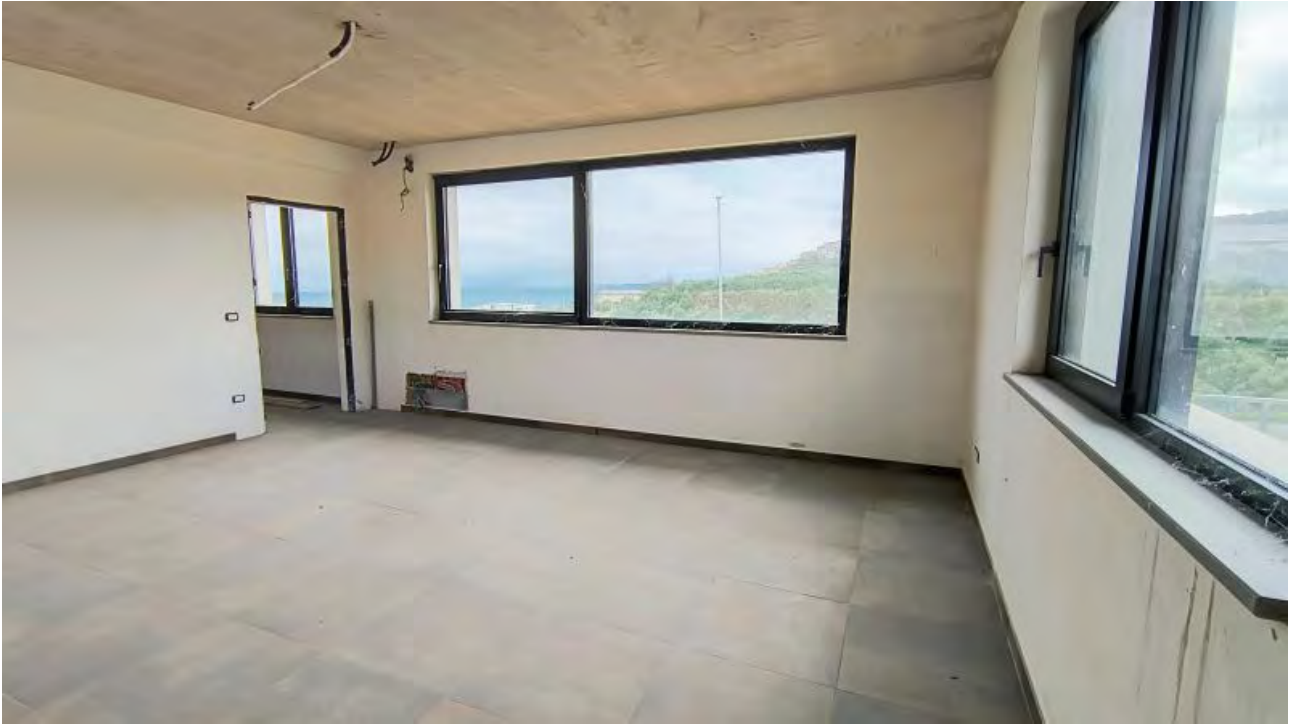
Foto 35 - Edificio uffici e servizi, camera piano primo ala Ovest.
