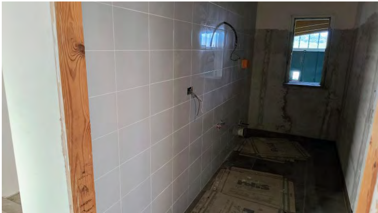
Foto 40 - Edificio uffici e servizi, bagno piano primo ala Ovest.
