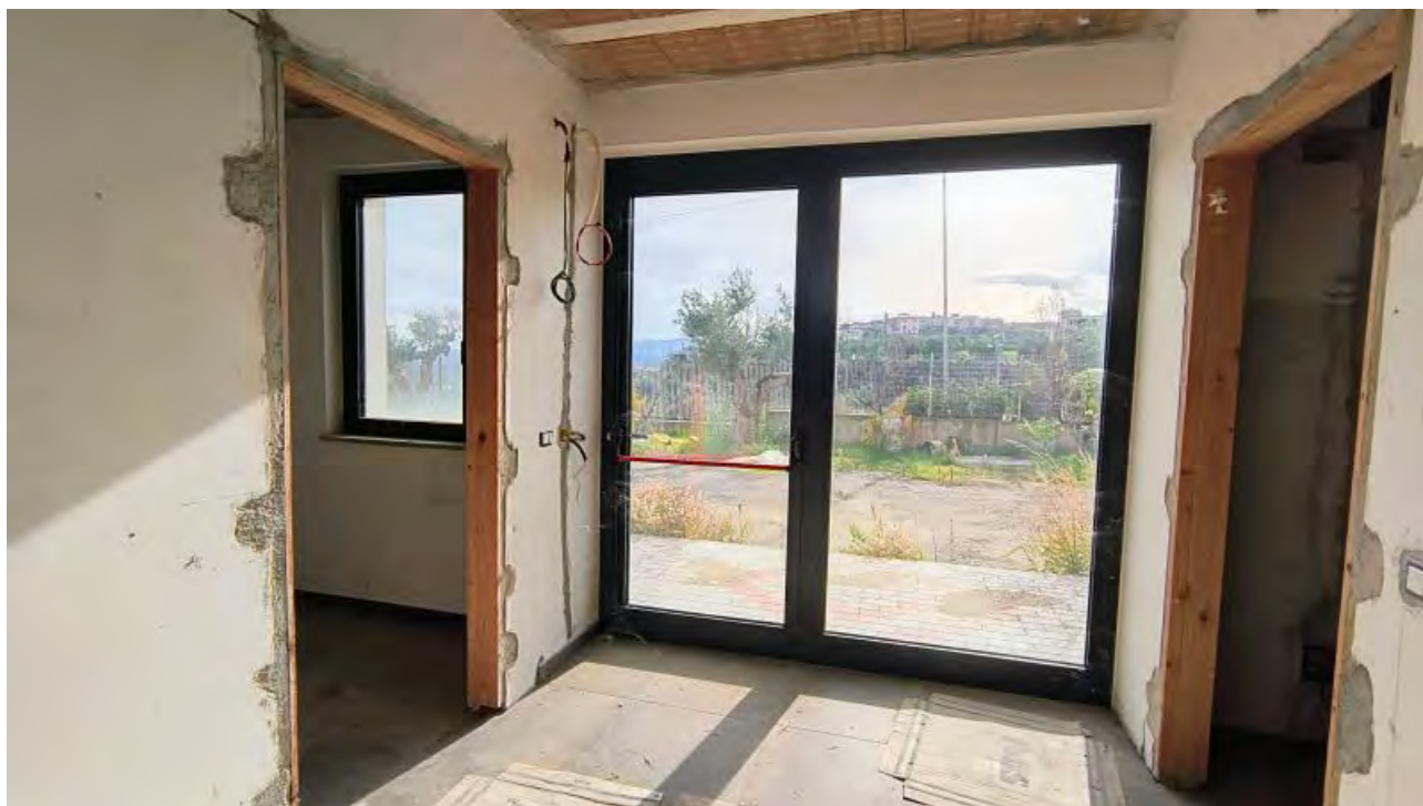
Foto 29 - Edificio uffici e servizi, piano terra, ingresso alla Est.
