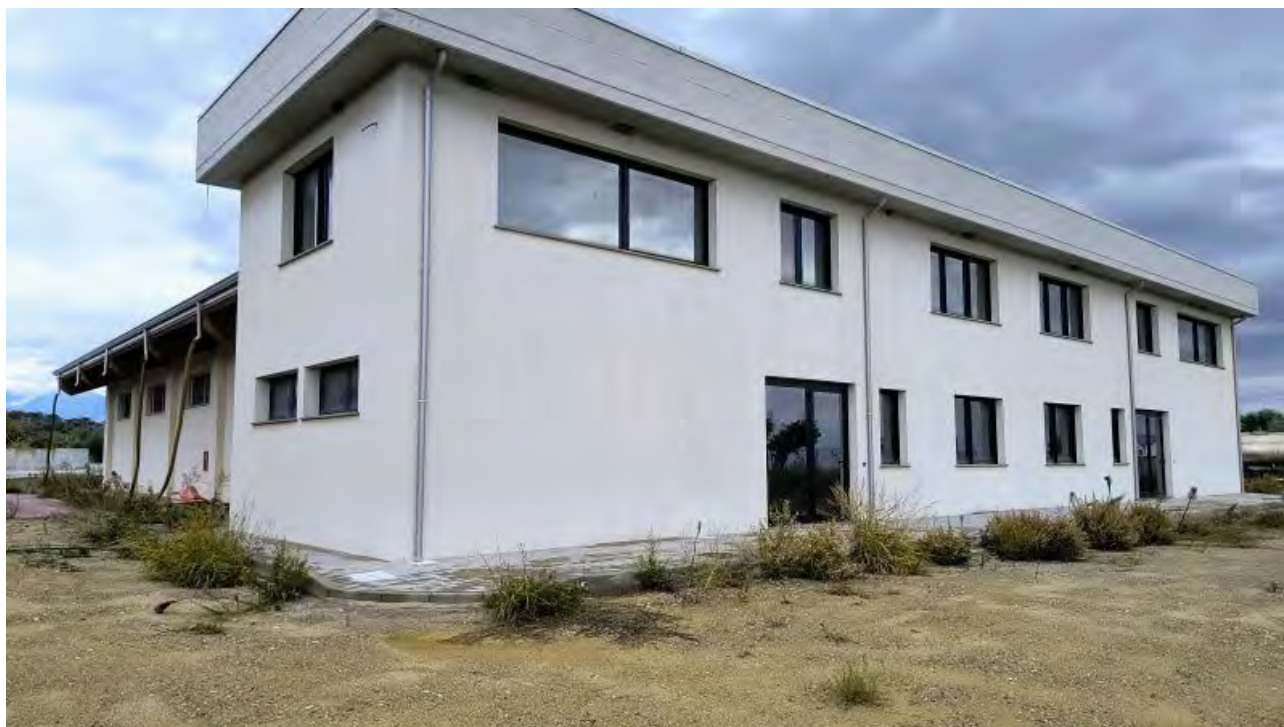
Foto 3 - Edificio uffici e servizi, prospetto Sud-Ovest.
