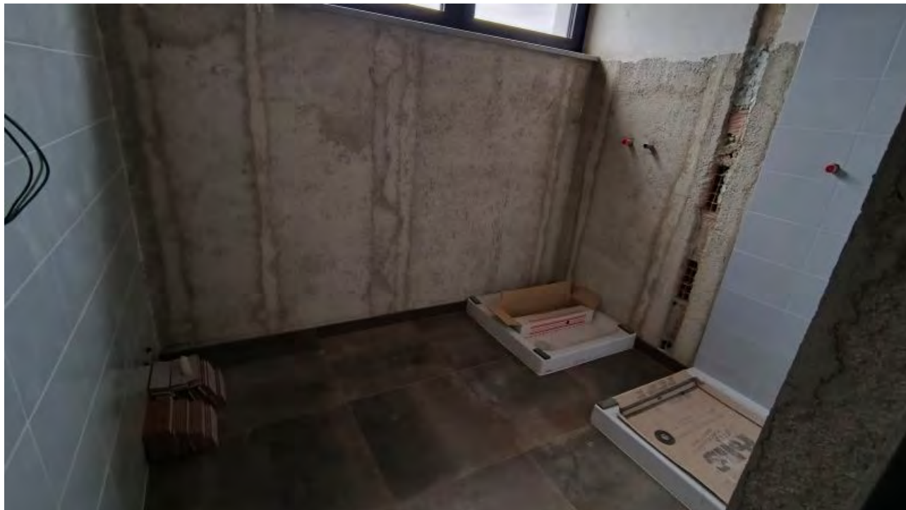
Foto 22 - Edificio uffici e servizi, spogliatoio e bagno ala Est, piano terra.
