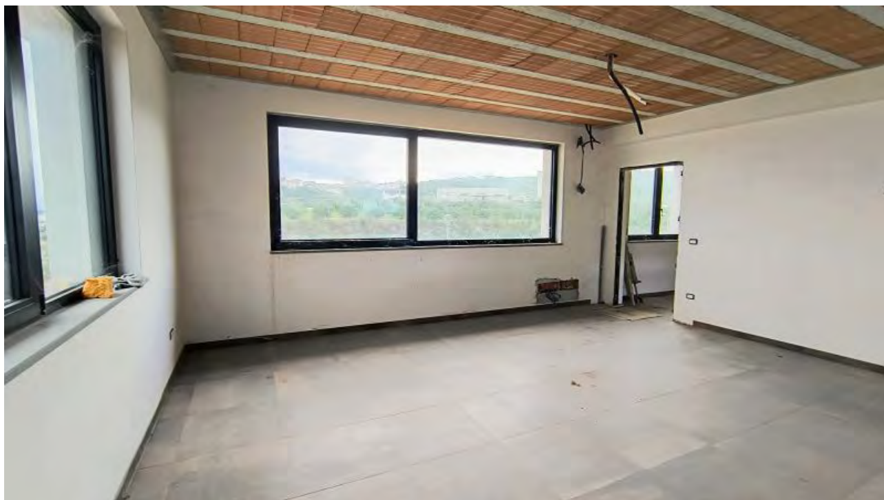
Foto 39 - Edificio uffici e servizi, camera piano primo ala Est.
