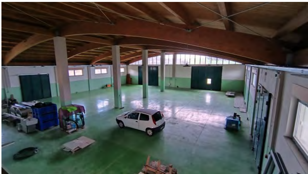
Foto 15 - Capannone produttivo, particolare interno.
