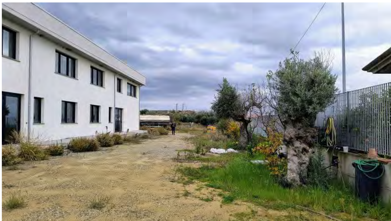
Foto 45 - Area esterna anteriore lato strada comunale (lato Sud).
