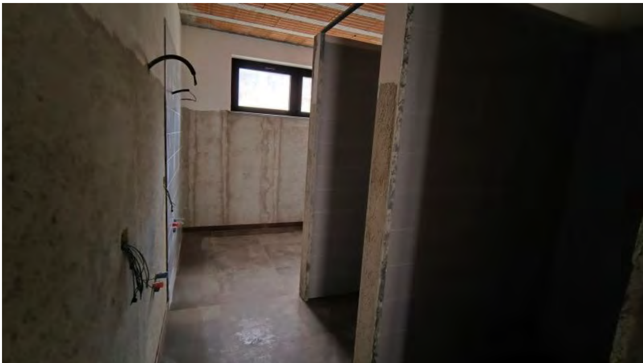
Foto 23 - Edificio uffici e servizi, spogliatoio e bagno ala Ovest, piano terra.
