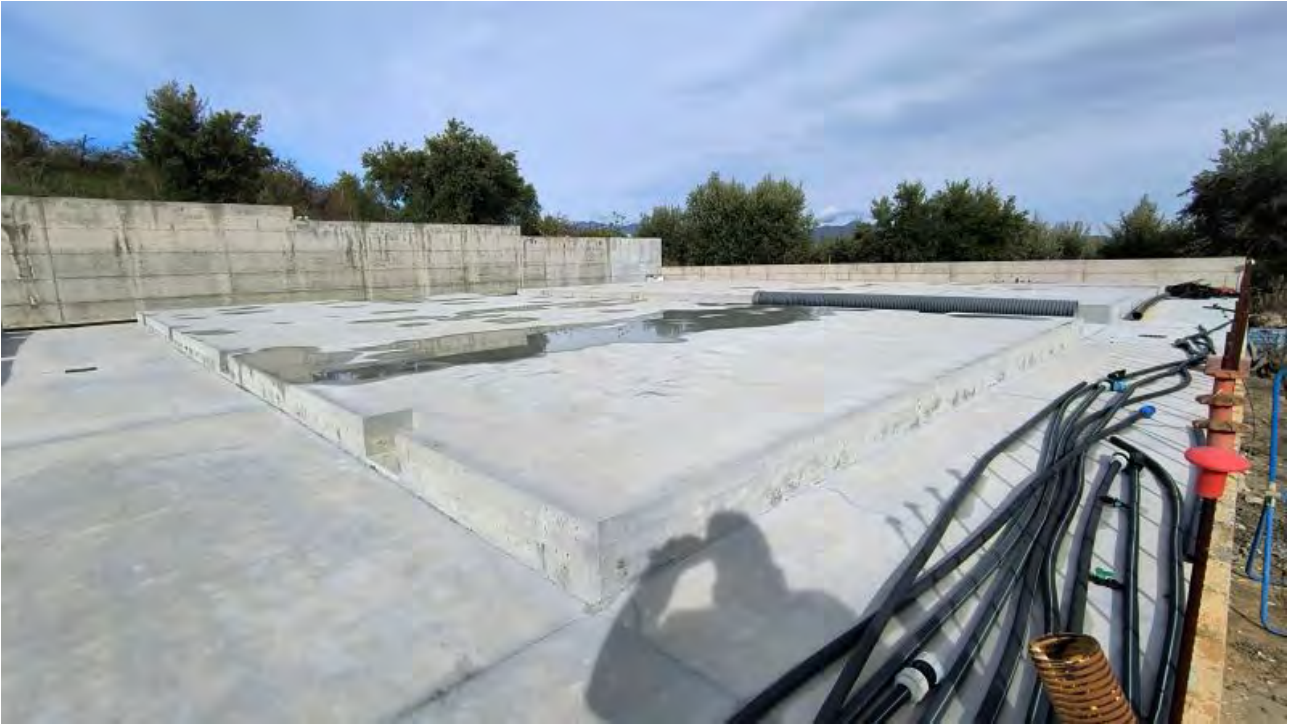
Foto 65 - Platea in c.a. basemento silos stoccaggio lato Nord.
