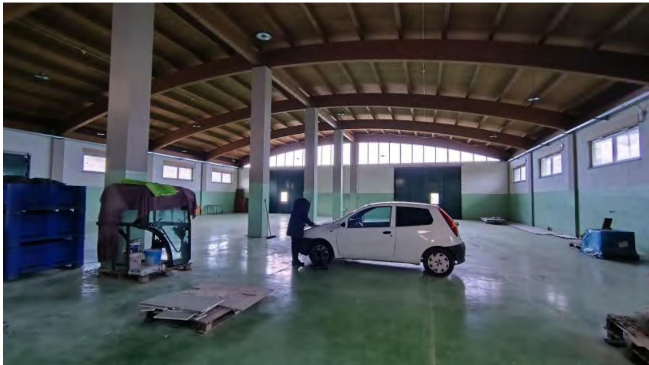
Foto 8 - Capannone produttivo, particolare interno.
