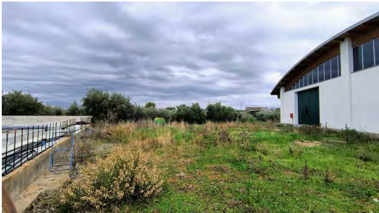
Foto 46 - Area esterna posteriore (lato Nord).
