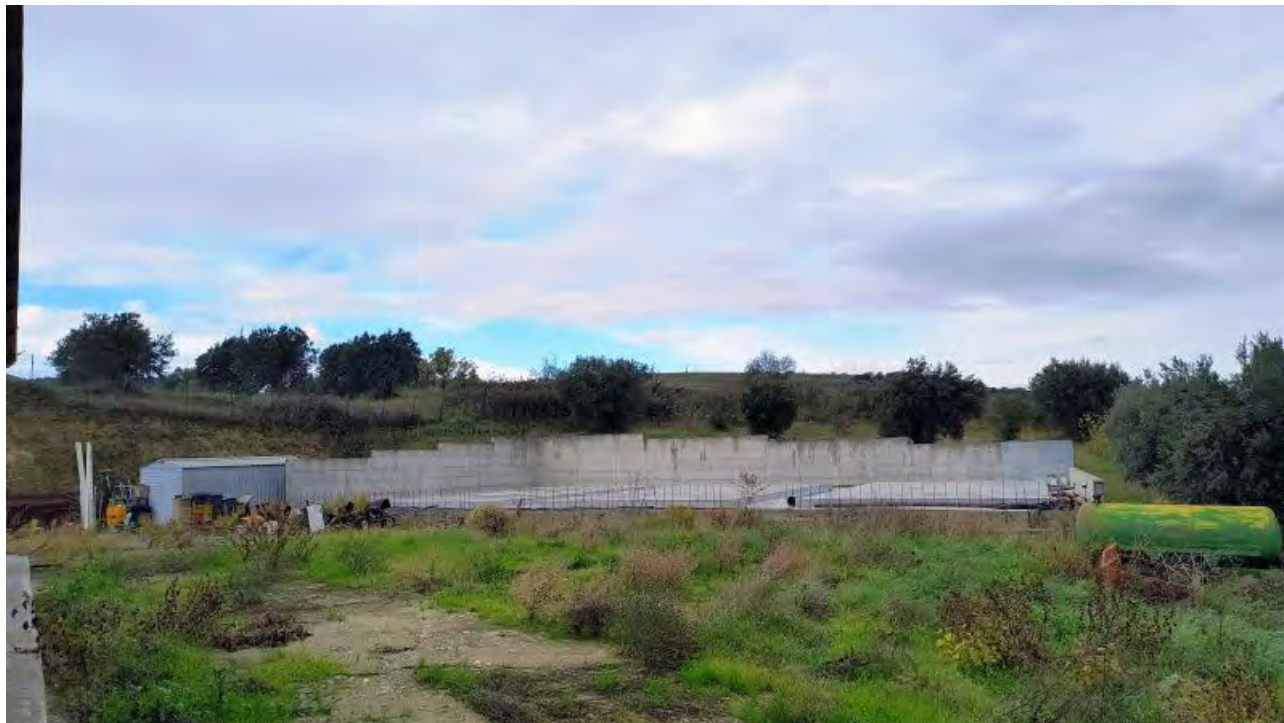
Foto 60 - Platea in c.a. basamento silos stoccaggio lato Nord.
