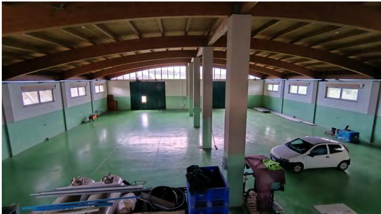
Foto 14 - Capannone produttivo, particolare interno.
