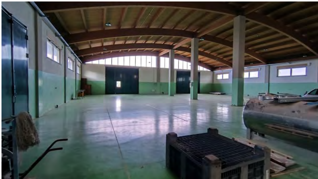
Foto 13 - Capannone produttivo, particolare interno.
