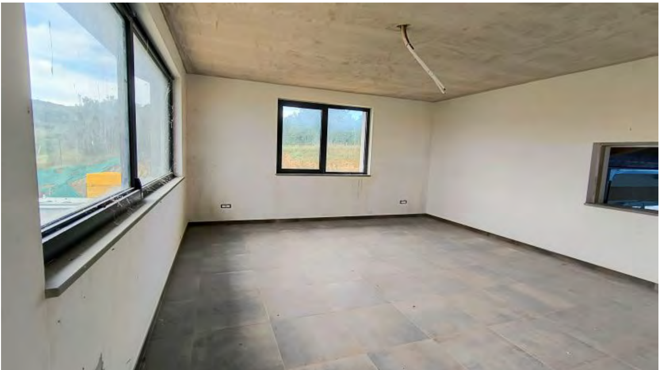
Foto 36 - Edificio uffici e servizi, camera piano primo ala Ovest.
