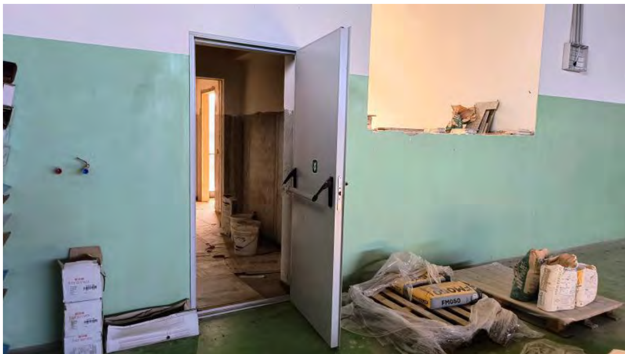
Foto 17 - Porta di comunicazione capannone produttivo con edificio uffici e servizi.
