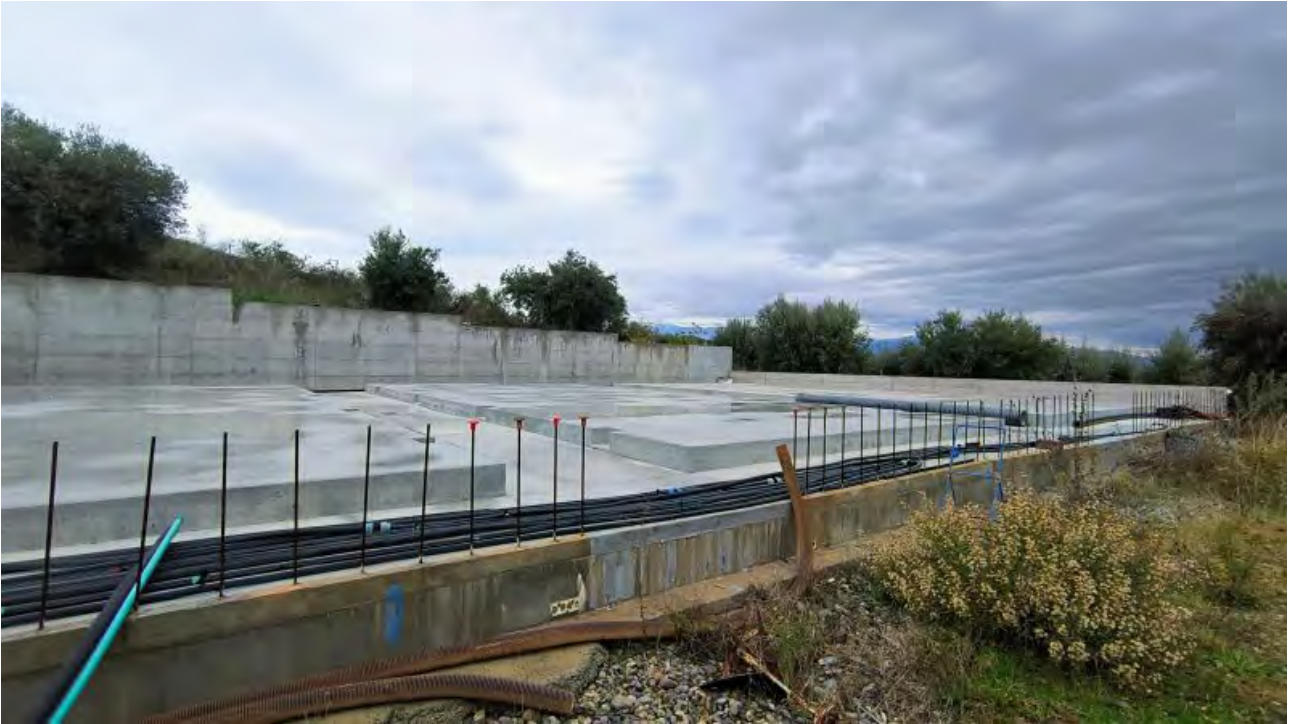
Foto 63 - Platea in c.a. basamento silos stoccaggio lato Nord.
