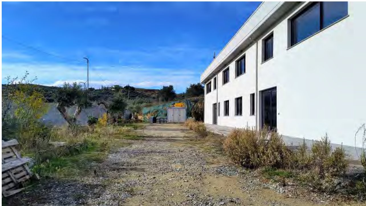
Foto 48 - Area esterna anteriore lato strada comunale (lato Sud).
