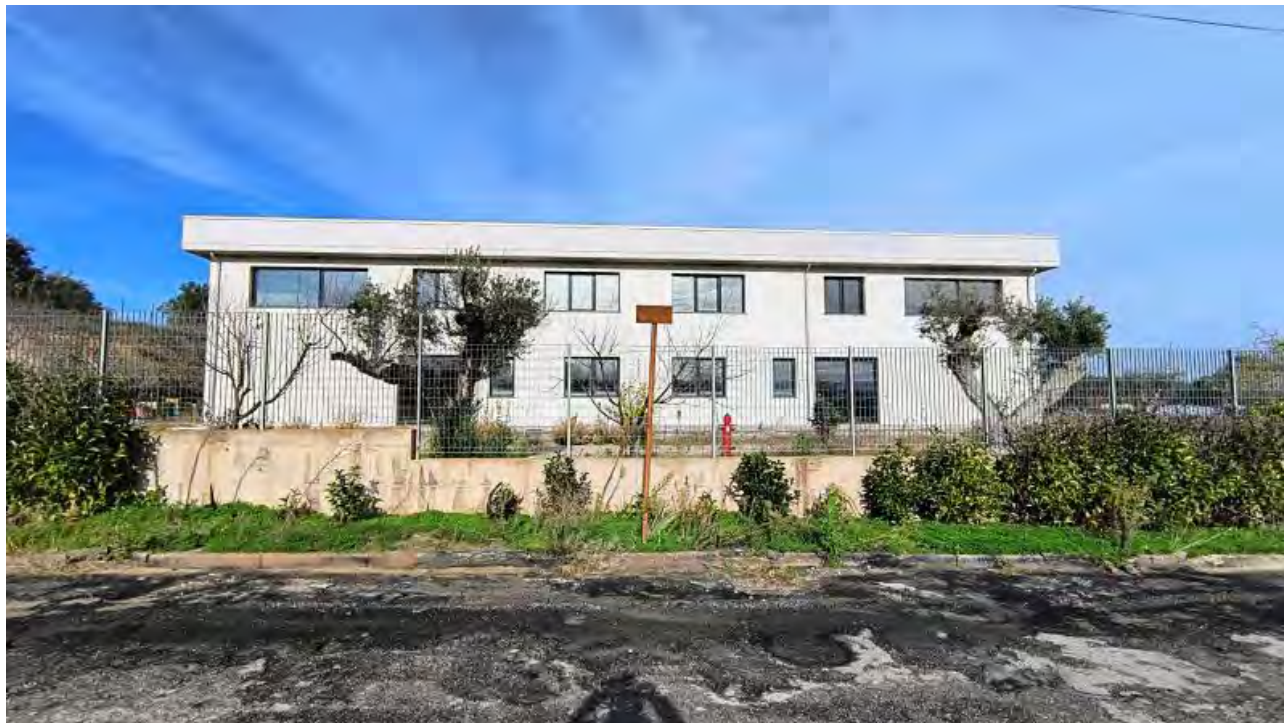
Foto 52 - Muro di recinzione lato strada comunale (lato Sud).
