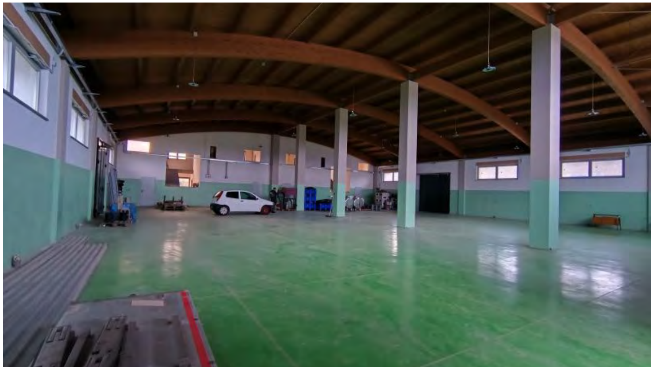
Foto 10 - Capannone produttivo, particolare interno.
