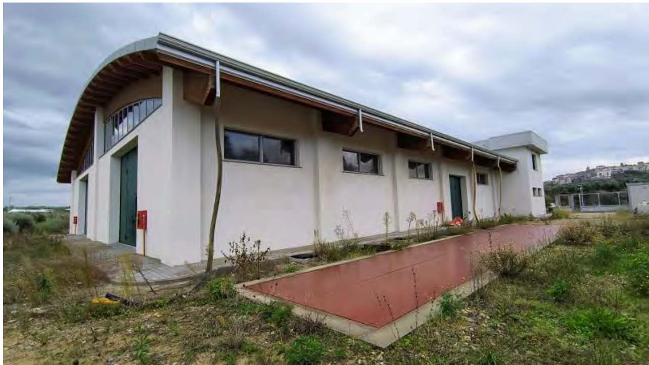
Foto 6 - Capannone produttivo e pesa a ponte, prospetto Ovest.
