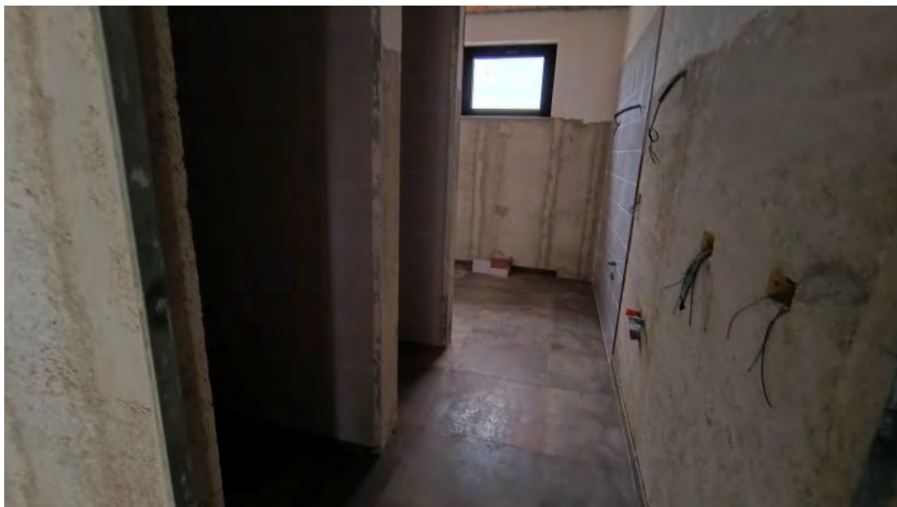
Foto 21 - Edificio uffici e servizi, spogliatoio e bagno ala Est, piano terra.
