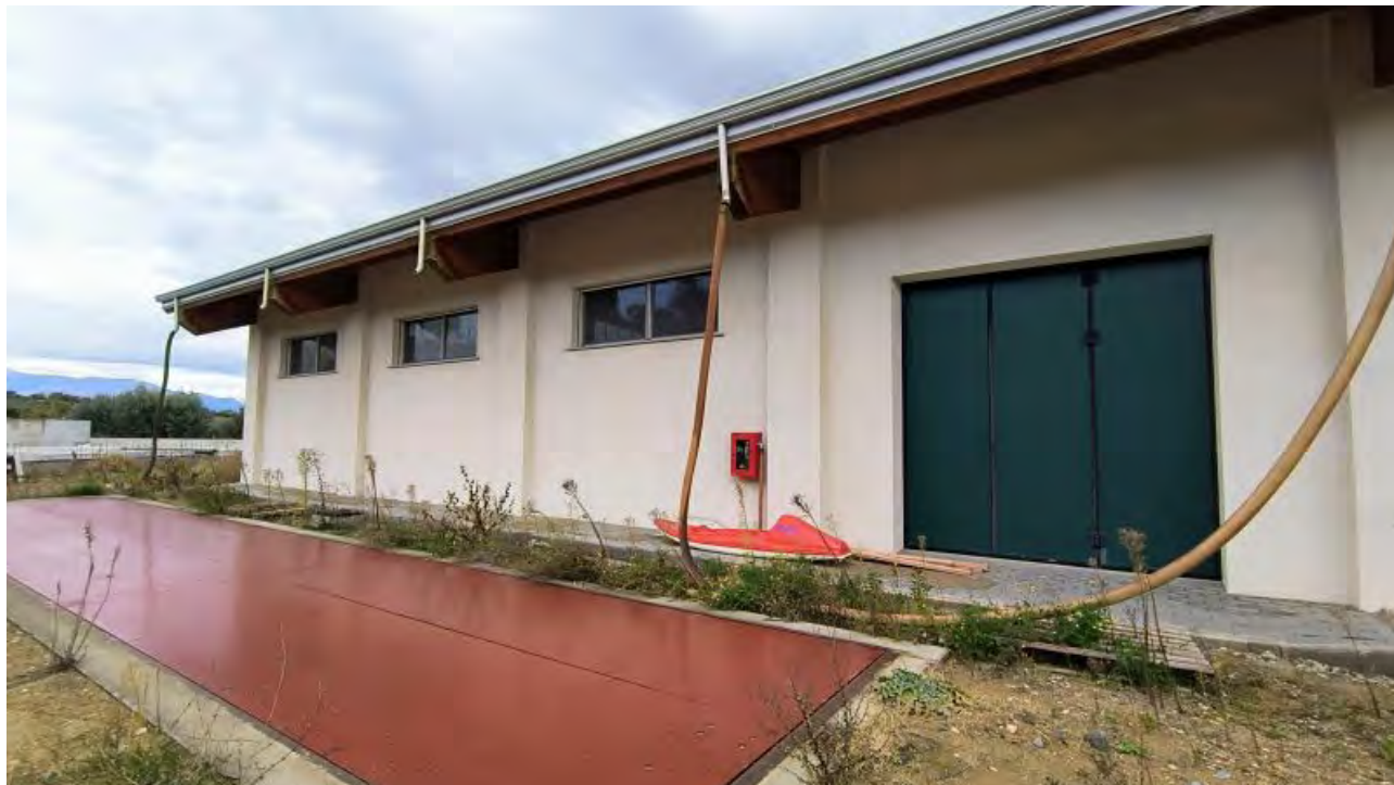
Foto 58 - Pesa a ponte lato Ovest capannone.
