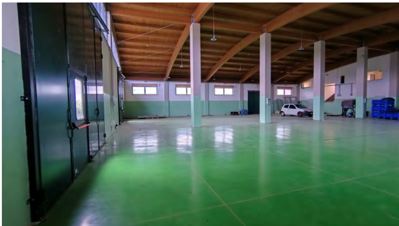
Foto 11 - Capannone produttivo, particolare interno.
