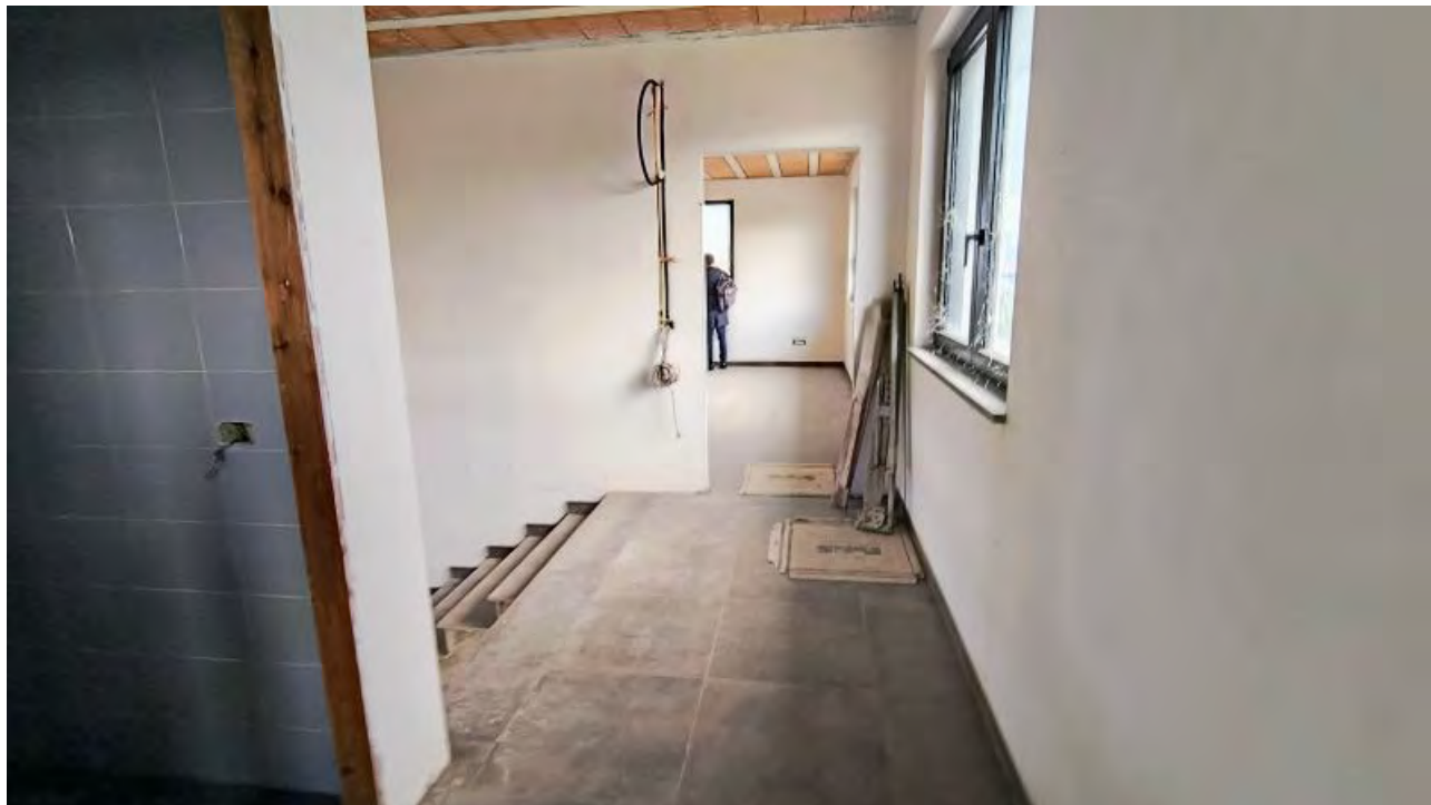
Foto 34 - Edificio uffici e servizi, piano primo, pianerottolo scala ala Est.
