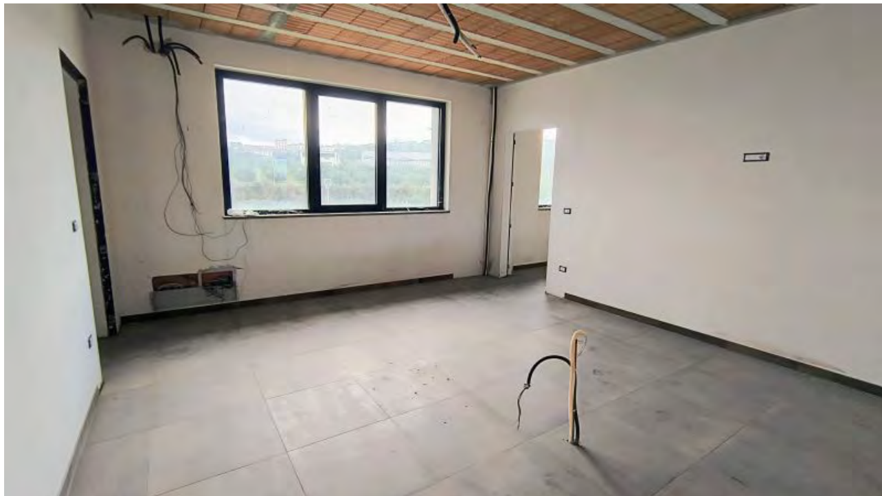
Foto 38 - Edificio uffici e servizi, camera piano primo.
