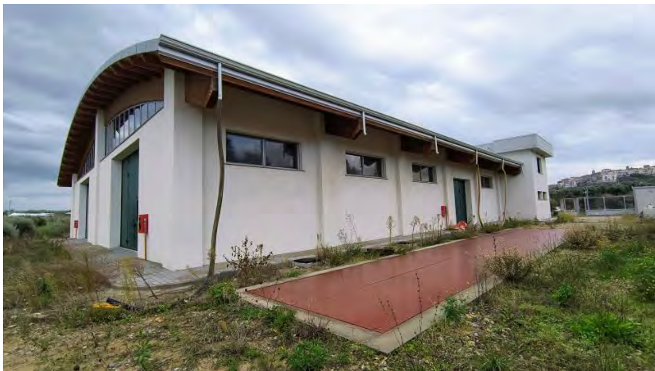
Foto 47 - Area esterna lato Ovest con pesa a ponte.
