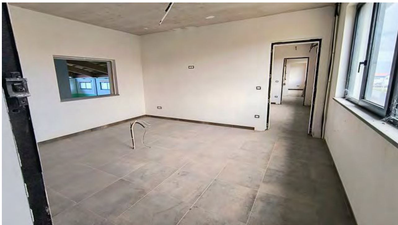
Foto 37 - Edificio uffici e servizi, camera piano primo.
