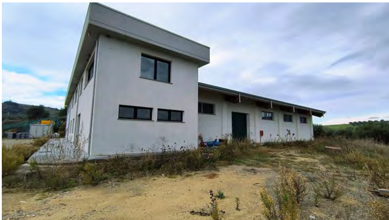
Foto 5 - Edificio uffici e servizi, prospetto Est.
