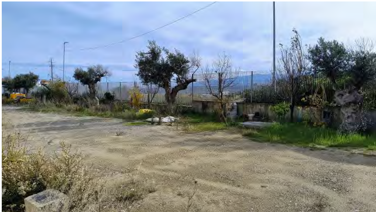
Foto 56 - Recinzione lato strada comunale (lato Sud).
