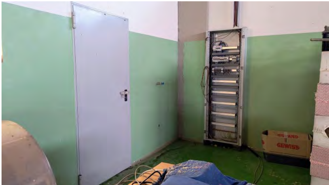
Foto 18 - Porta di comunicazione capannone produttivo con edificio uffici e servizi.
