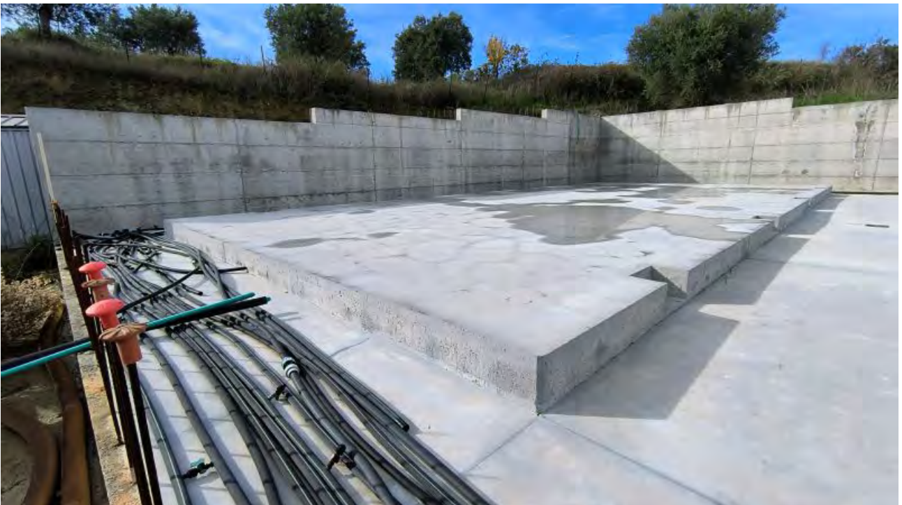
Foto 64 - Platea in c.a. basamento silos stoccaggio lato Nord.
