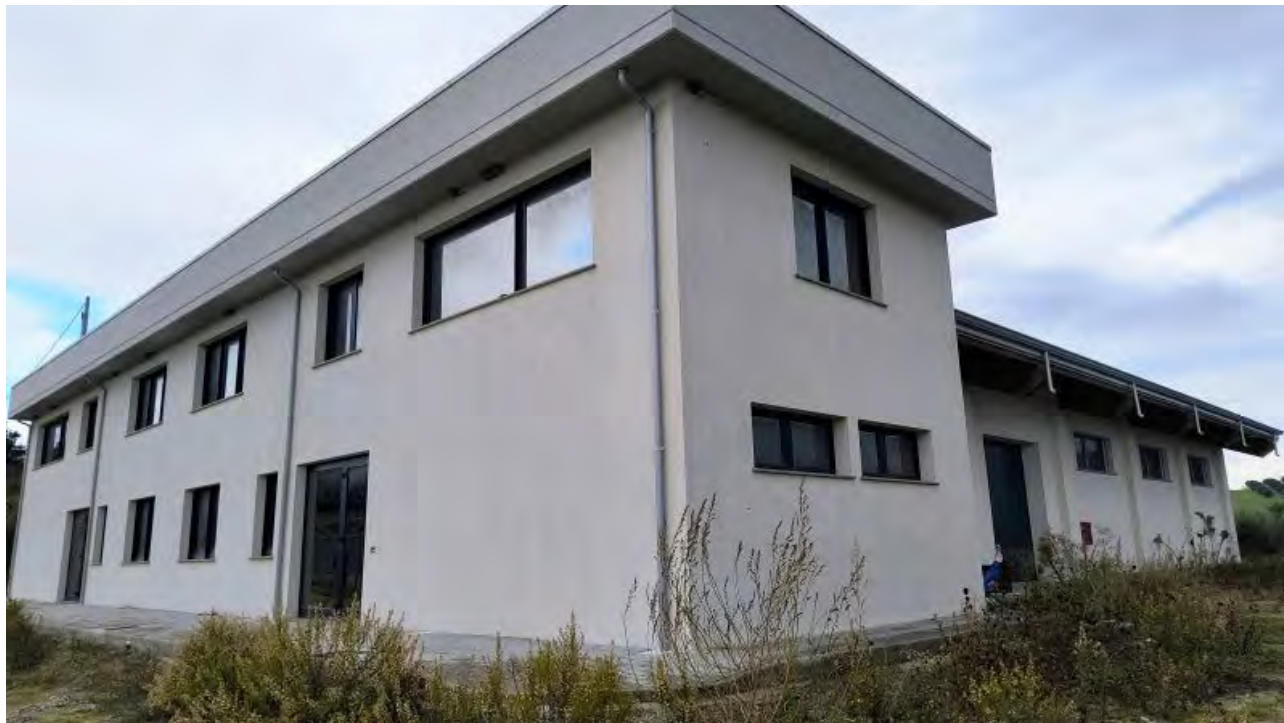
Foto 4 - Edificio uffici e servizi, prospetto Sud-Est.
