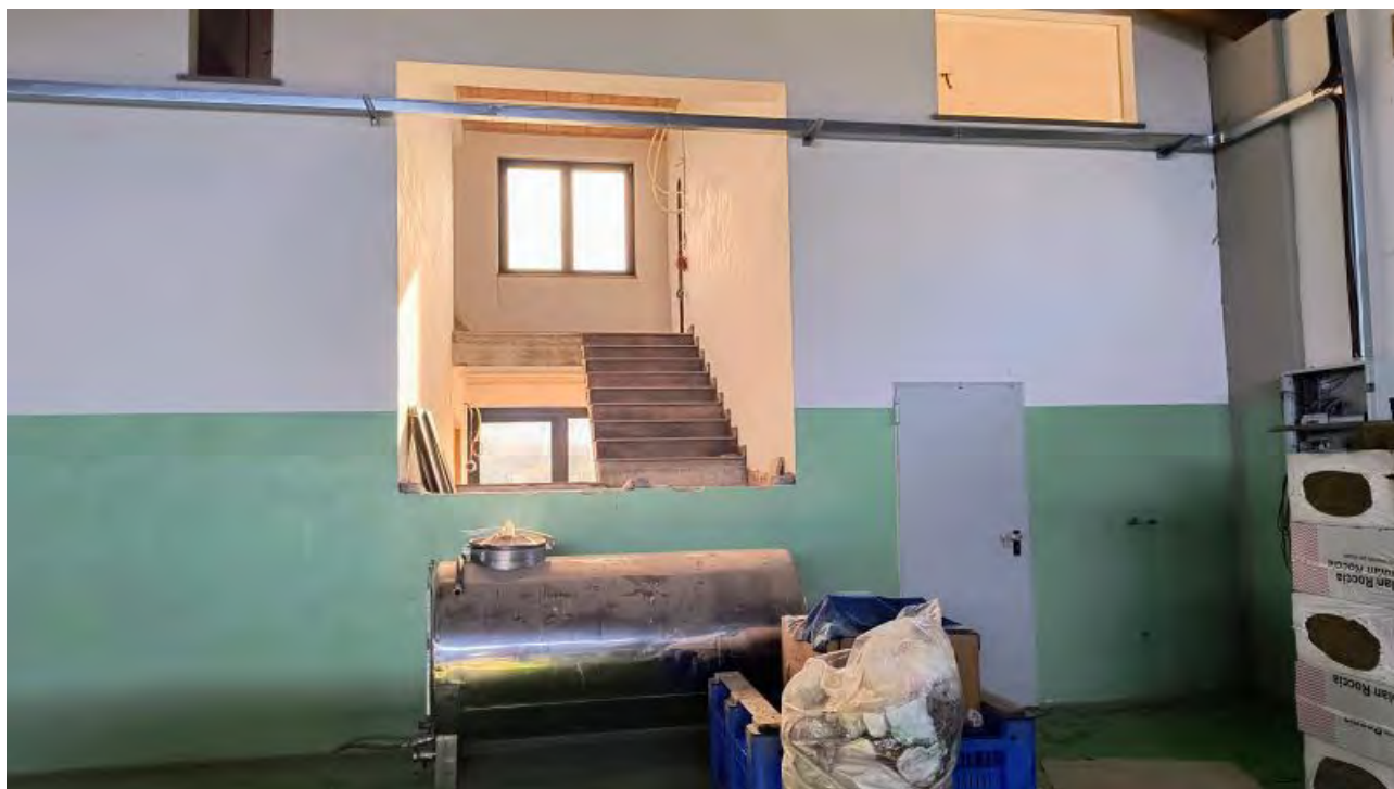
Foto 43 - Vano scala edificio uffici e servizi aperto ala Ovest.
