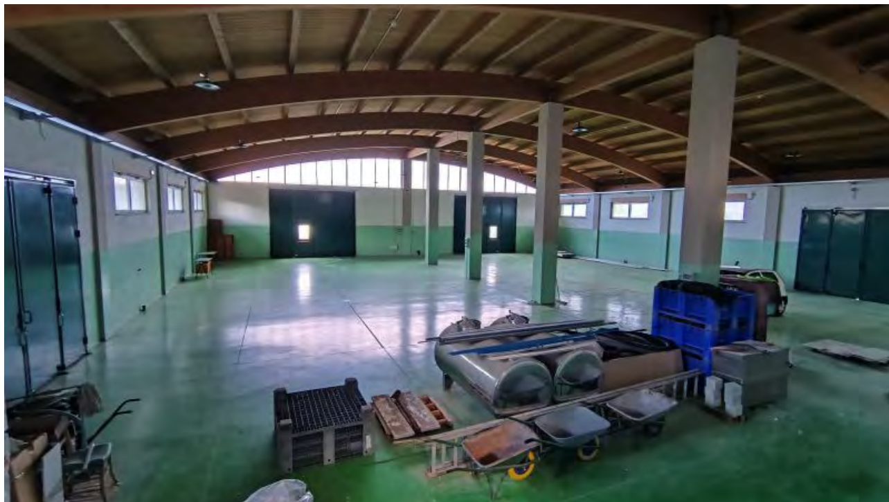
Foto 69 - Attrezzature, materiali e residui nel capannone produttivo.
