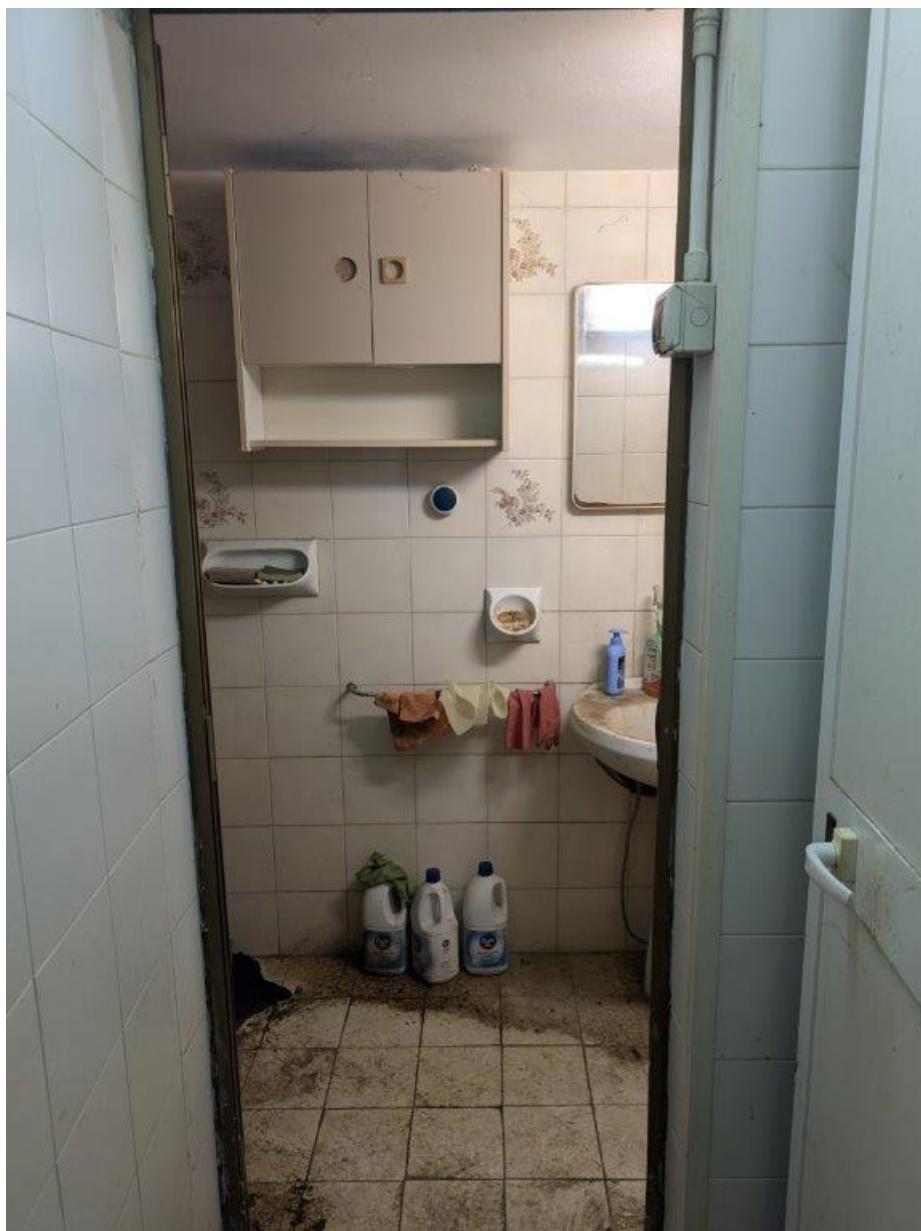
Figura 13 Disimpegno e antibagno Piano terra
