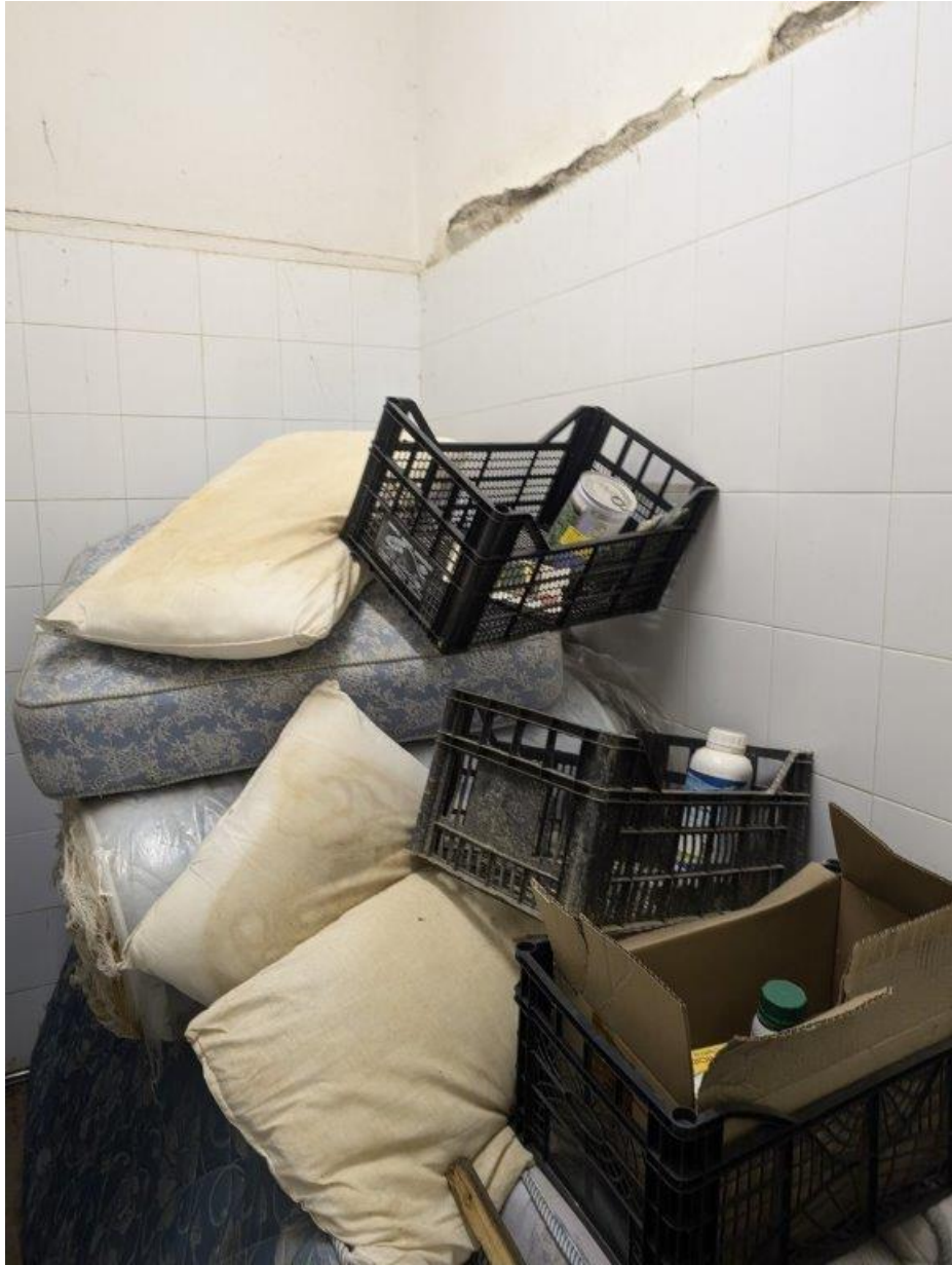
Figura 14 Ripostiglio Piano Terra
