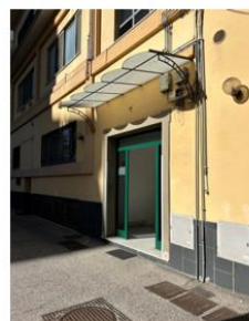
Foto n. 5 - Ingresso al fabbricato
