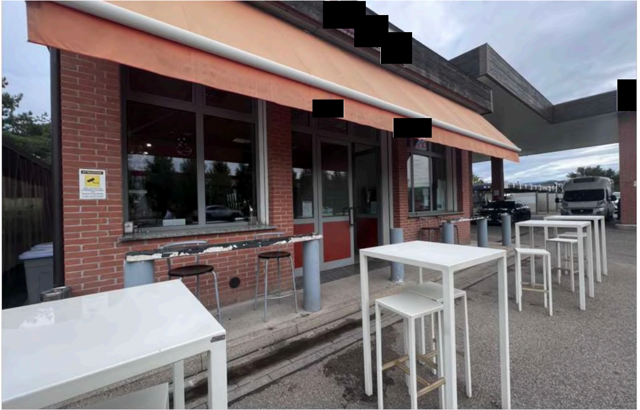
FOTO 3 - Fronte Est sub. 6 e 7
