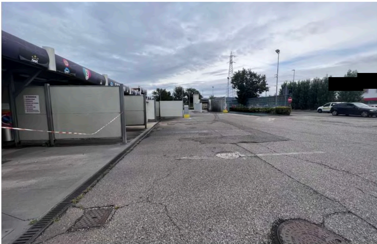
FOTO 5 - Autolavaggio sub. 3 e 5
