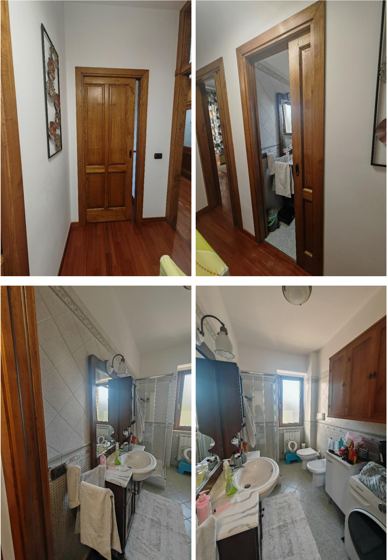
Figura 10: interno appartamento (disimpegno/wc)
