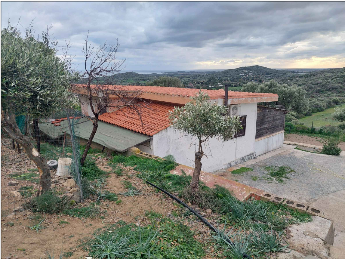
CORPO PRINCIPALE VISTO DAL SENTIERO
