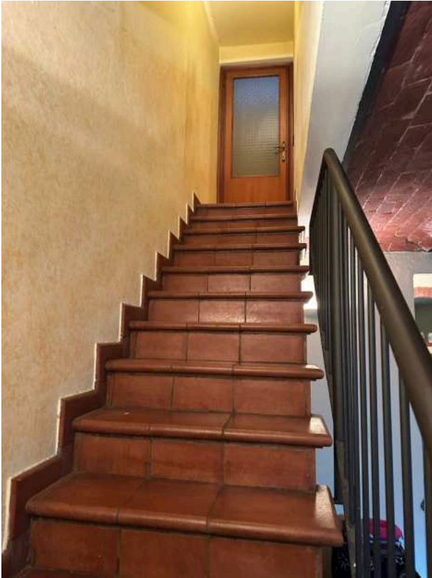
Scale per accedere al Piano Primo
