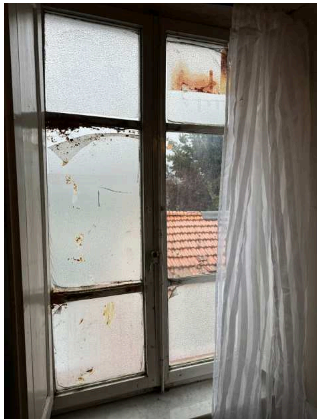
Particolare finestra (Bagno)
