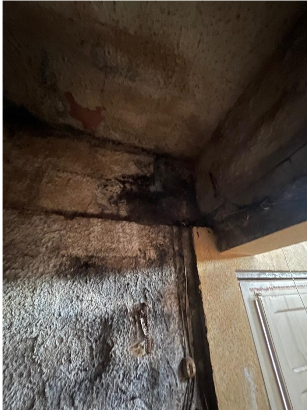
29 PIANO 2° terrazza coperta – particolare
