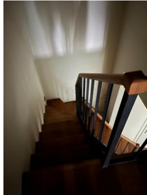
Immagine 37: Foto scala interna privata con accesso al piano superiore dell'alloggio.
