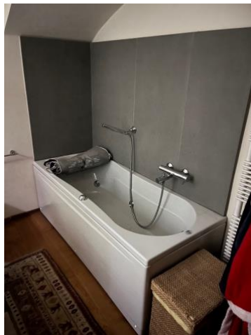
Immagine 45: sala da bagno al piano superiore, completa.
