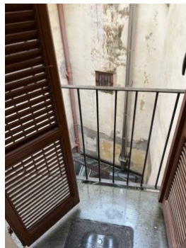
Immagine 47: balconcino della sala da bagno, esposizione su cavedio interno
