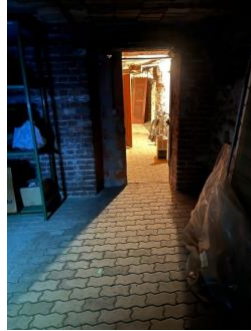
Immagine 55: Foto cantina al piano seminterrato.
