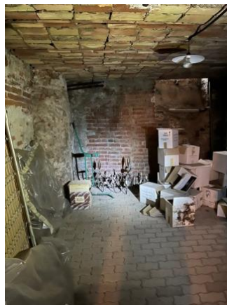
Immagine 54: Foto cantina al piano seminterrato.
