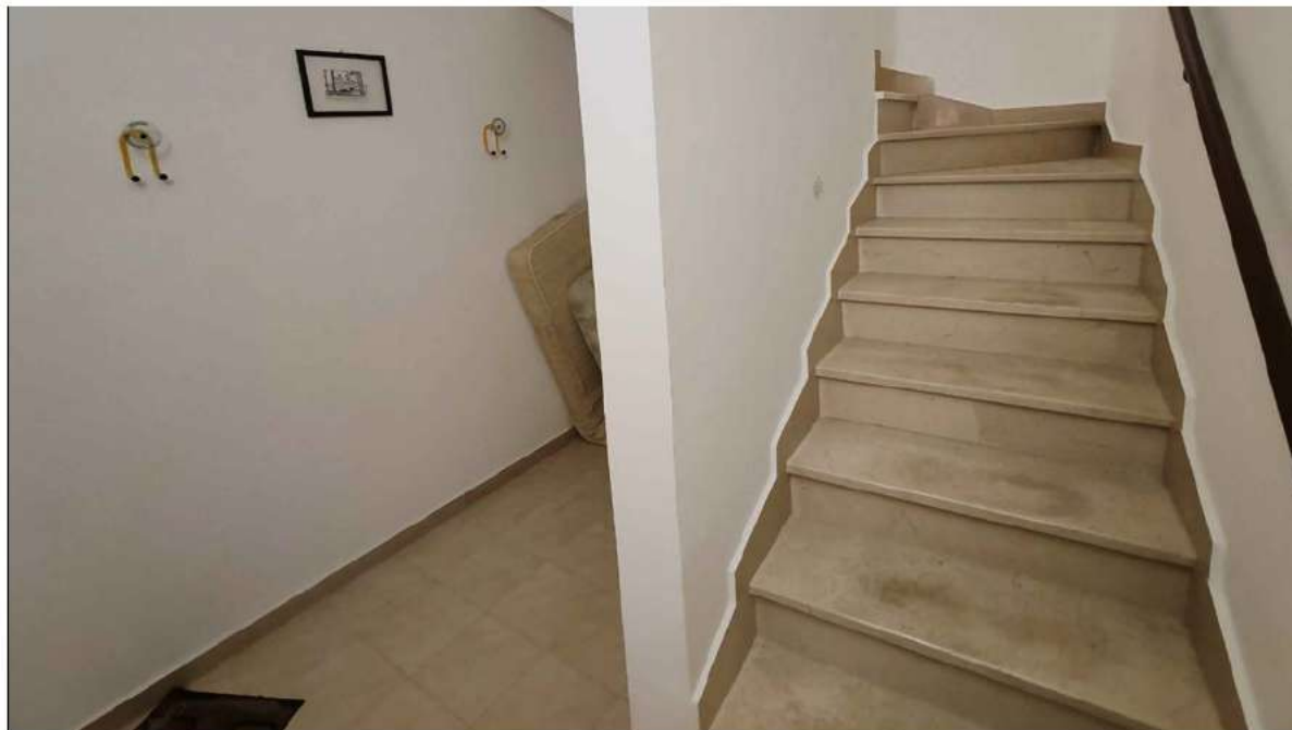
foto 3 - vista del vano scala d'ingresso al piano T.
