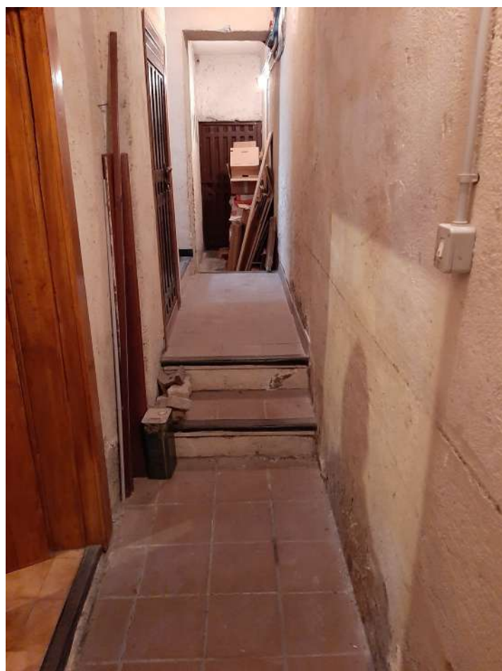
Foto n.14 (corridoio locali interrati)
