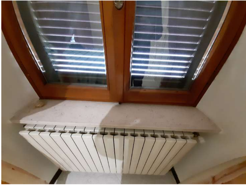
Foto n.16 (particolare infisso esterno)
