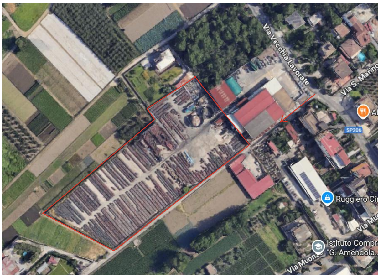
Foto 1: fonte Google Earth, inquadramento satellitare con indicazione degli immobili oggetto di valutazione.
