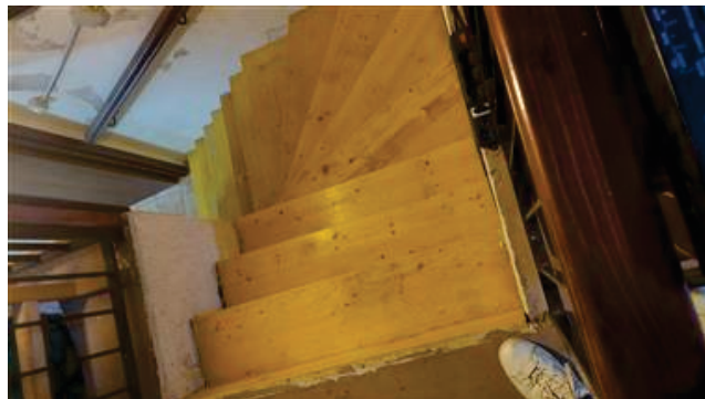
Scala legno sottotetto
