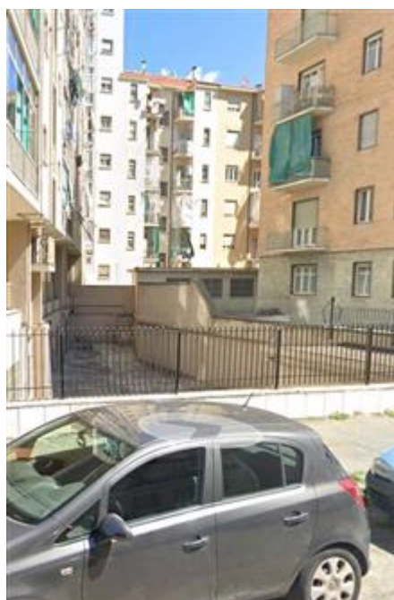
Vista su prospetto interno cortile
