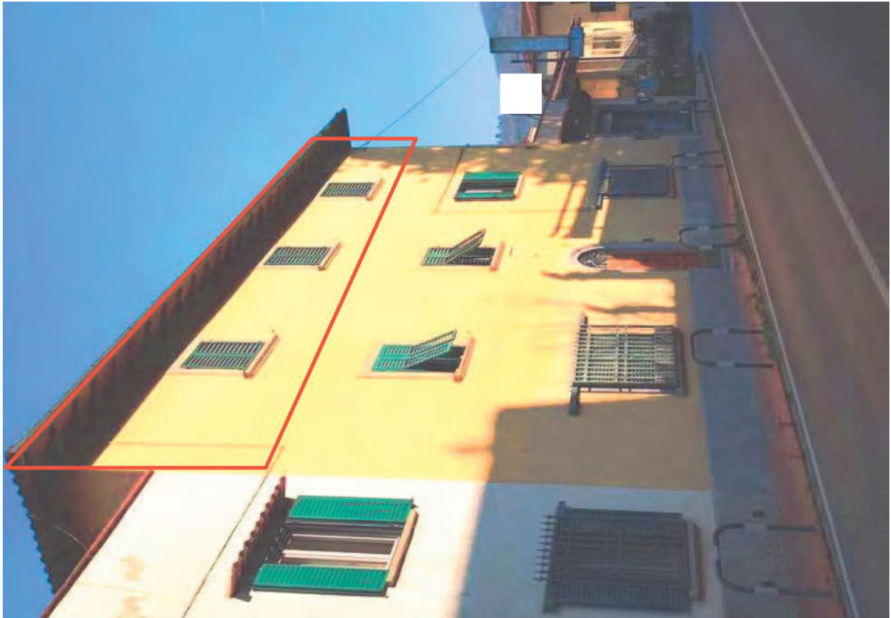
Foto 3 – Vista prospetto principale SUD-EST
