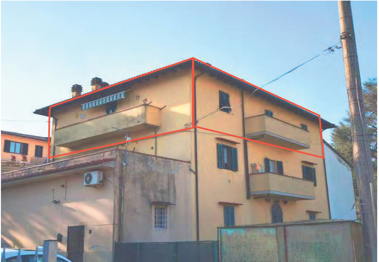
Foto 5 – Vista prospetto laterale/tergale NORD
