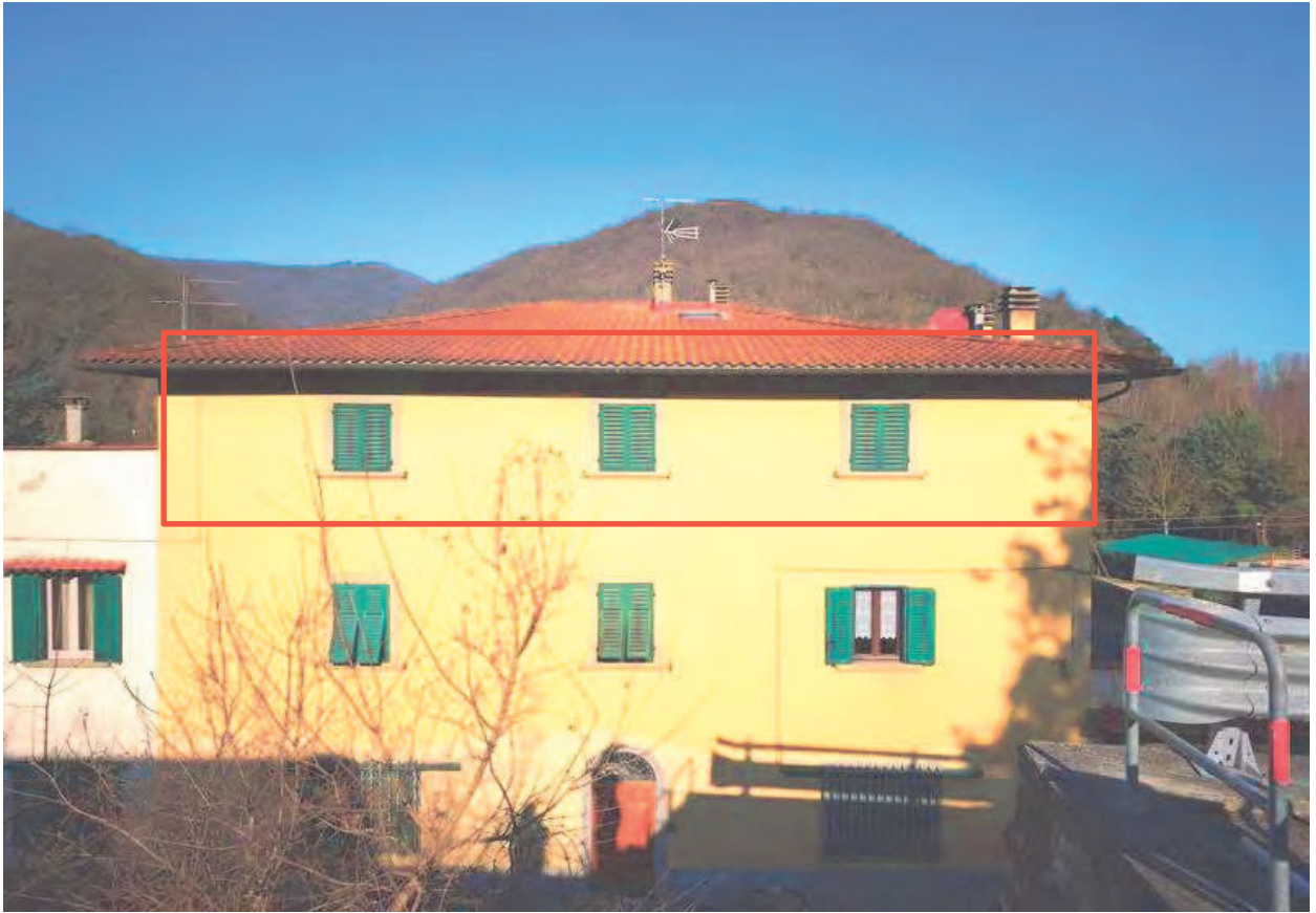
Foto 1 – Vista prospetto principale SUD-EST
