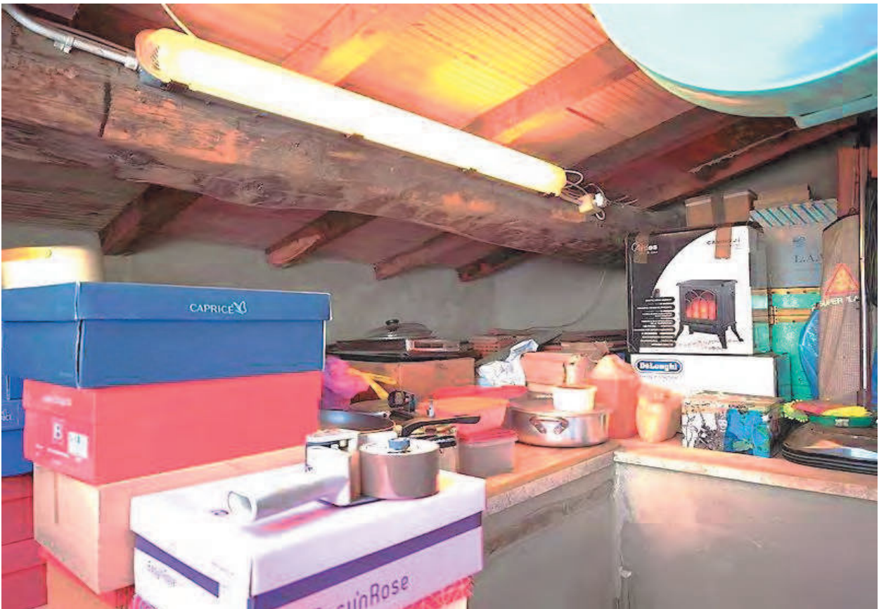
Foto 36– Piano terzo – ripostiglio/CT/lavanderia/soffitta sottotetto
