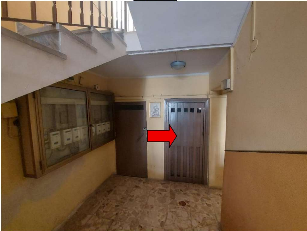
Piano seminterrato – accesso cantina
