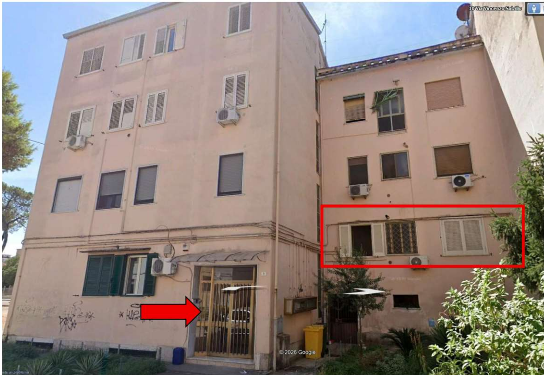
via Salzillo – accesso civ.5 – affacci cespite
