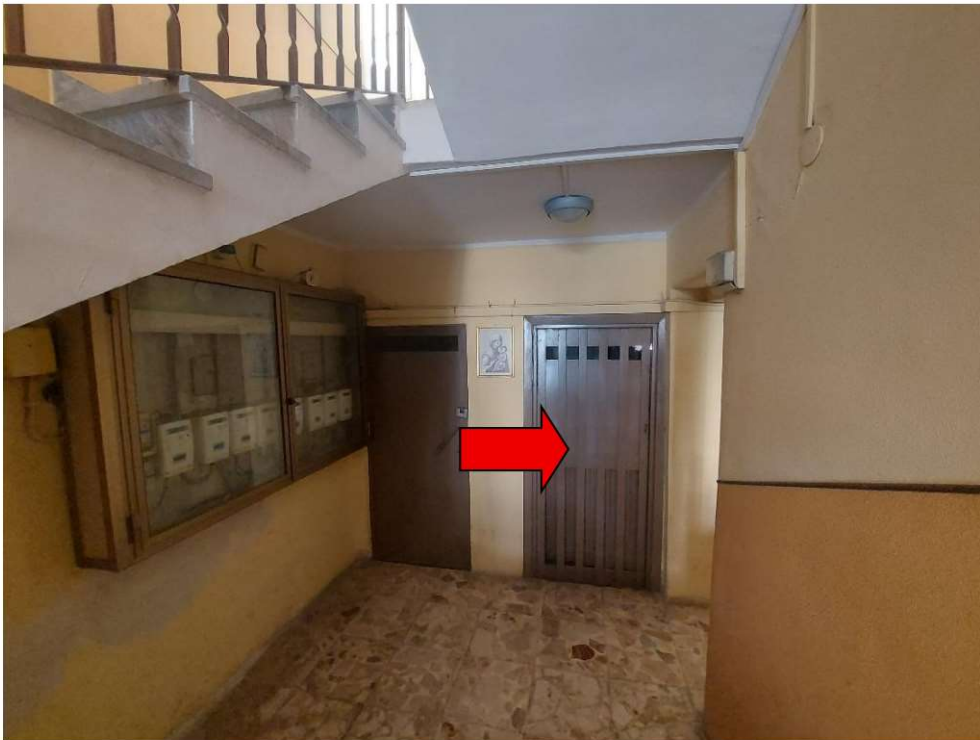
Piano seminterrato – porta accesso cantina
