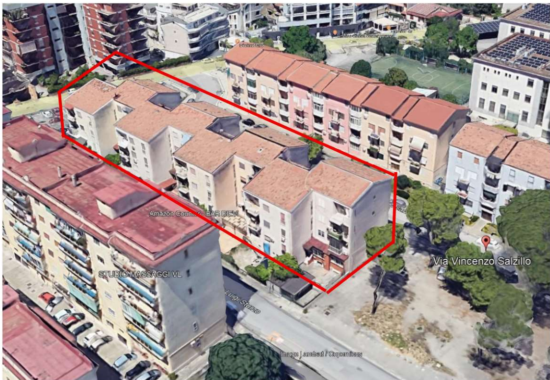
Prospetto sud fabbricato versante via Sturzo
