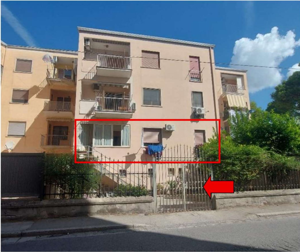
Prospetto sud fabbricato versante via Sturzo – accesso corte pertinenza e affacci cespite
