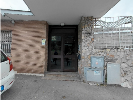
Accesso al fabbricato
