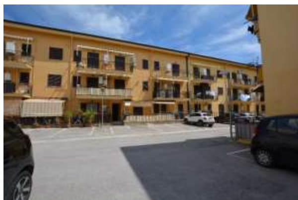
Foto 3 - Edificio di Via Bari n. 18 ad Aspra
