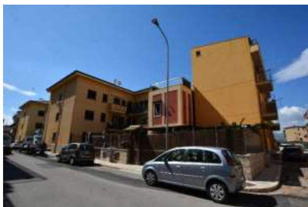
Foto 1 - Palazzina di Via Andrea Doria/Via Bari 18
