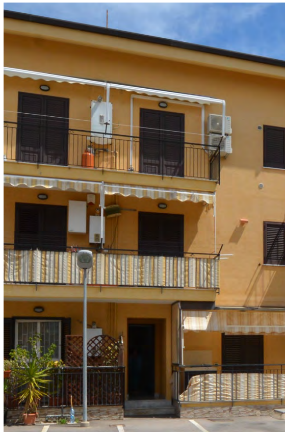
Foto 3 – Edificio di Via Bari n. 18 a Bagheria Frazione di Aspra
