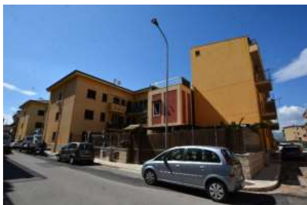
Foto 1 - Palazzina di Via Andrea Doria/Via Bari 18
