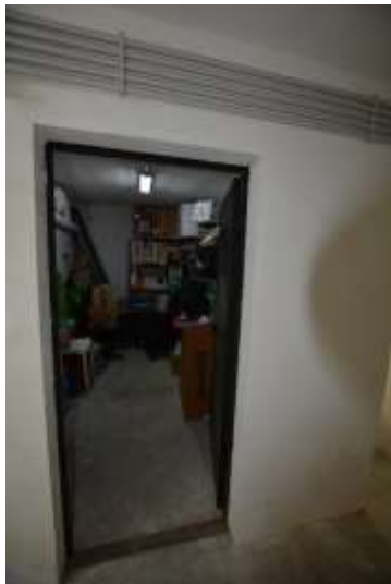
Foto 7 - Ingresso magazzino da corridoio condominiale
