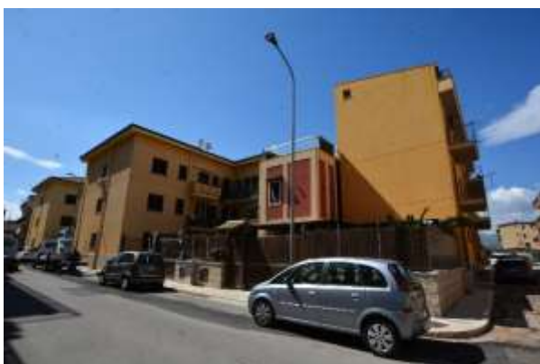
Foto 1 - Palazzina di Via Andrea Doria/Via Bari 18
