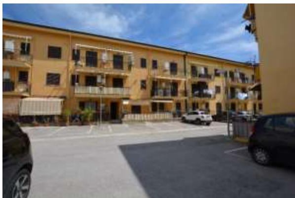
Foto 3 - Edificio di Via Bari n. 18 ad Aspra
