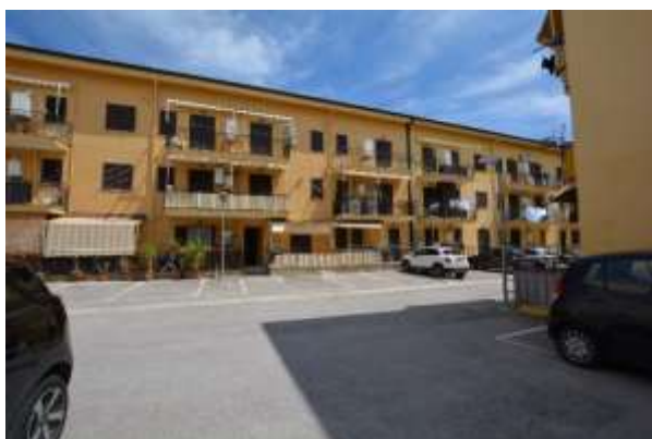
Foto 3 - Edificio di Via Bari n. 18 ad Aspra
