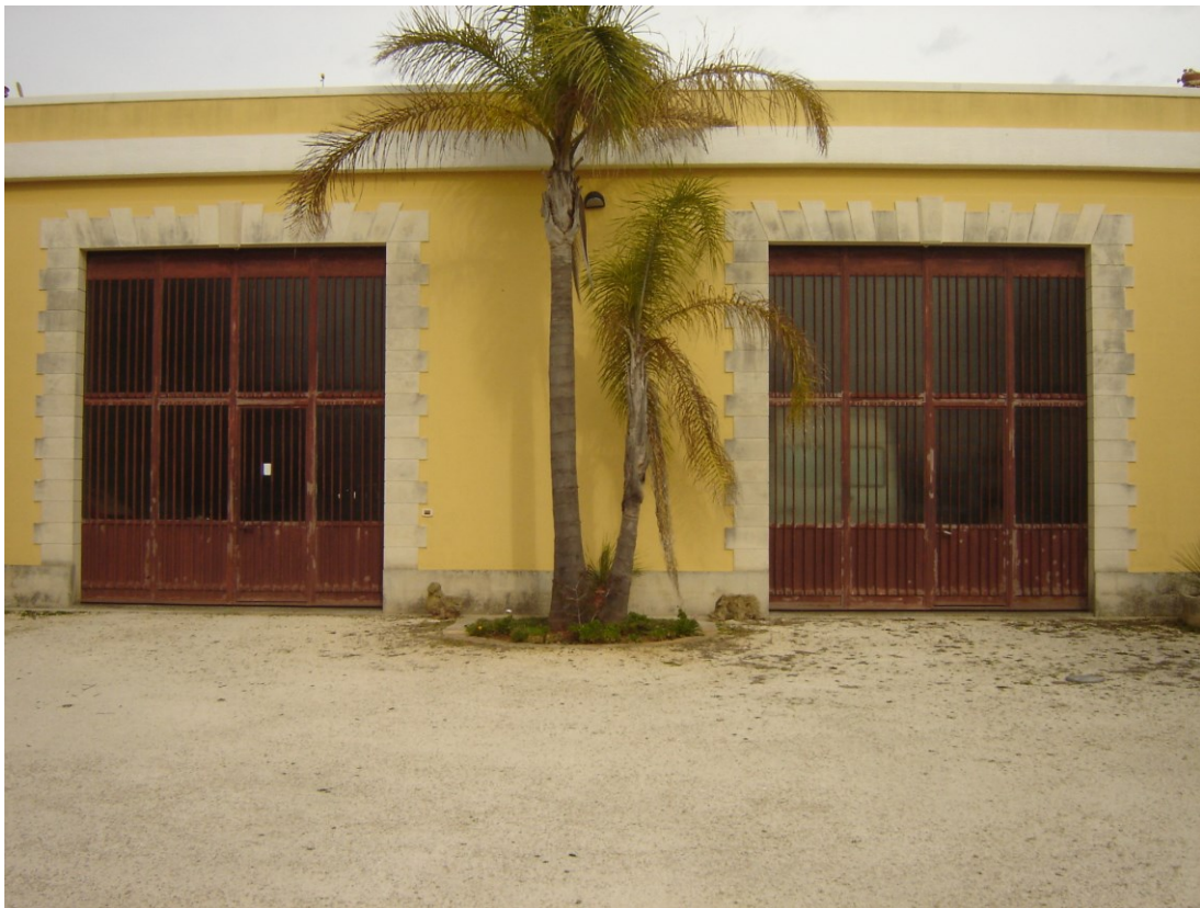
FOTO 1 (Ingresso locale artigianale)
