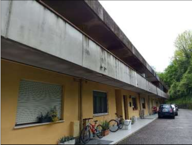
Foto 6 – strada di accesso a comune con altre U.I.
