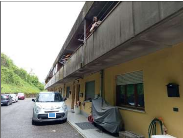
Foto 5 – strada di accesso a comune con altre U.I.
