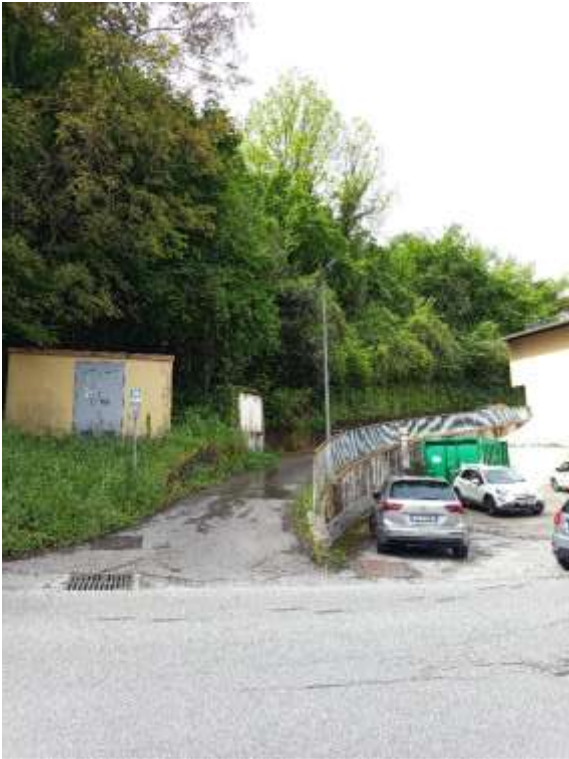
Foto 4 – strada di accesso a comune con altre U.I.
